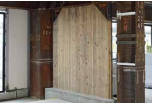
（仮称）泉区高森2丁目プロジェクト 鉄骨造との混構造。柱は大臣認定を取得している木質耐火部材。耐力壁はCLT。本とりまとめでは部材ハイブリッドで分類。
