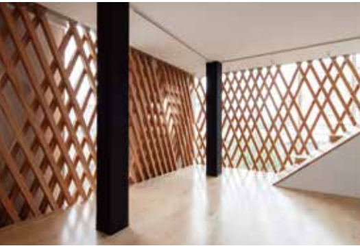
下馬の集合住宅プロジェクト 2～5階が1時間の耐火木造（被覆型）。水平力を負担する斜め格子を現しとして木造らしさを表現。
