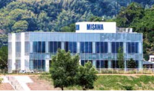
ミサワホーム事務所ビル新築工事 接着パネル工法
