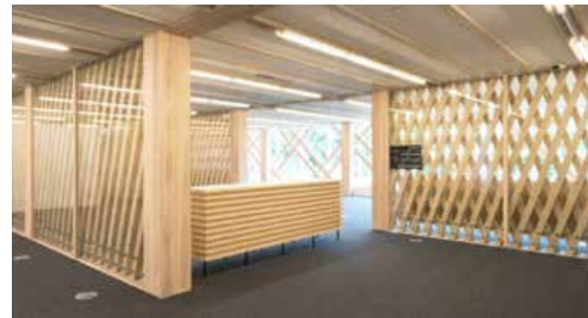
紫波町新庁舎整備事業 1時間準耐火構造とRC造棟を挟むことによって延床6,650m 2 の事務所を実現。
