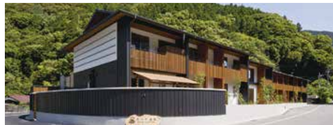
北川村温泉ゆずの宿改築工事 RC造別棟を挟み「その他建築物」で延床1,475㎡を実現。
