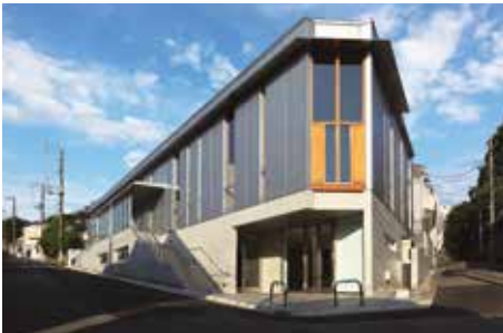
神奈川大学 横浜キャンパス 国際センター 教育施設・学校：屋根架構
