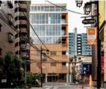
国分寺フレーバーライフ社本社ビル新築工事 ハイブリッド構法
