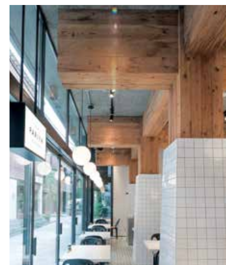
柳小路南角Ⅱ期新築工事 一般流通している集成材で重ね梁、製材で束ね柱を構成し燃えしろ設計で準耐火構造を実現している。
