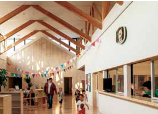
厚沢部町認定こども園新築工事 ロ準耐1号を利用して内部を木造化。
