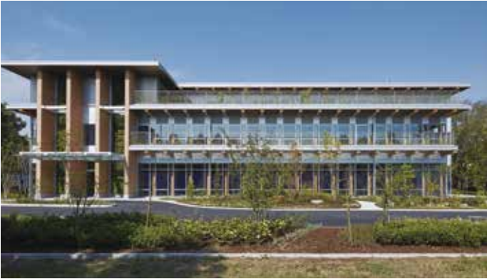
住友林業筑波研究所新研究棟新築工事 全館避難安全検証により、マッシュホルツによる耐力壁・カラマツ集成材の柱・CLTの床版を木の現しにすることが可能に。
