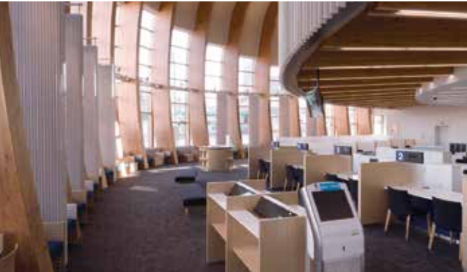
北見信用金庫紋別支店新築工事 RC造の2階建てのコアに湾曲集成材を用いた大屋根で店舗部分を吹き抜けとしている。
