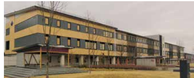
紫波町新庁舎整備事業 1時間準耐火構造とRC造棟を挟むことによって延床6,650m 2 の事務所を実現。
