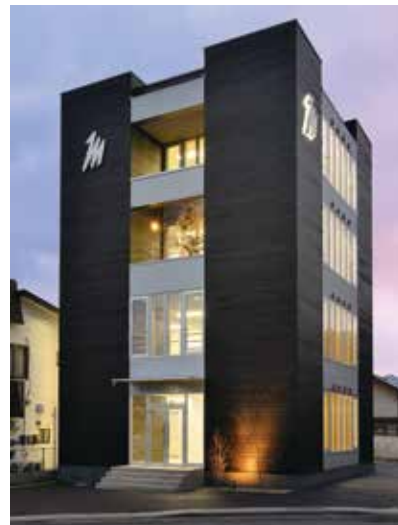
（仮称）4階建 エム・グループ本社ビル新築工事 ツーバイフォー高耐力壁（SSW-14）を使用したオープン工法による
