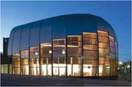
北見信用金庫紋別支店新築工事 屋根架構
