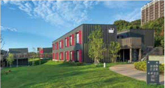
(仮称)ハウステンボススマートホテルプロジェクト CLTパネル工法
