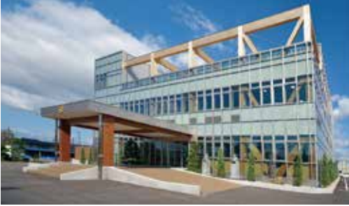
新発田ガス新社屋建設工事 大断面集成材構法
