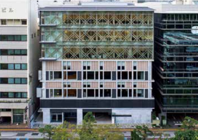
高知県自治会館新庁舎建築工事 地上6階のうち、1〜3階がRC造、4〜6階が木造となった立面混構造の耐火建築物。水平力のみ負担するブレースの木を現しとし木造らしさを表現。
