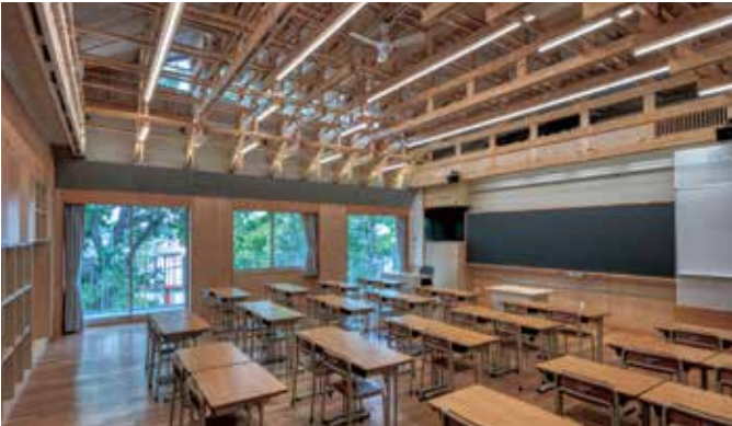
成城学園初等学校本校舎建替工事 RC造の外壁にて口準耐とし屋根を製材の重ね梁としている。
