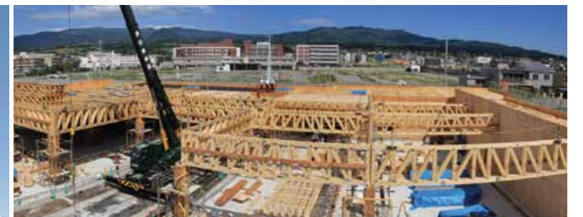
（仮称）コープさっぽろエコ店舗計画（桝組壁工法による大規模エコ店舗） 地上1階、準耐火建築物、延べ面積約3,000 m²
