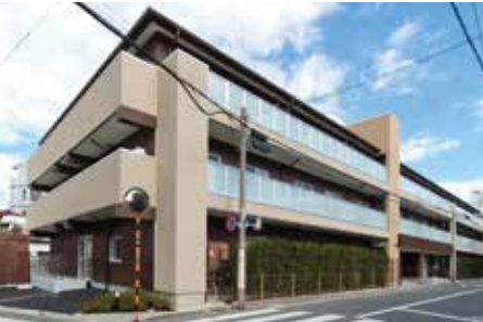
大田区矢口木造老人ホームプロジェクト 桢組壁工法
