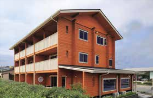
入間ログハウス3階建て複合施設 建設工事 複合施設（事務所・共同住宅・飲食店）
