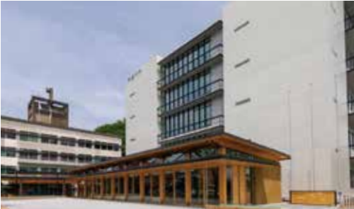
長門市本庁舎建設事業 ハイブリッド構法
