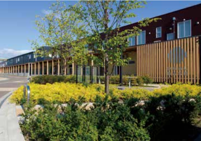
オガールベース整備事業 木造、RC造、S造の棟が一直線に並んだ平面混構造の複合施設。延焼の恐れが無く理想的な平面計画となっている。
