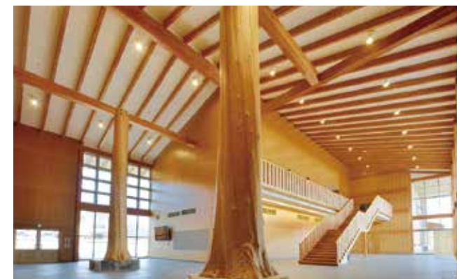
朝日村新庁舎建設工事 信州型接着重ね梁、カラマツ集成厚板パネルを床に活用。2層吹き抜けとなっている村民交流ホールには、シンボルとして樹齢300年のヒノキを活用。
