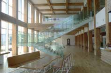
（仮称）ボラテックビル新築工事 ハイブリッド構法（部材ハイブリッド）
