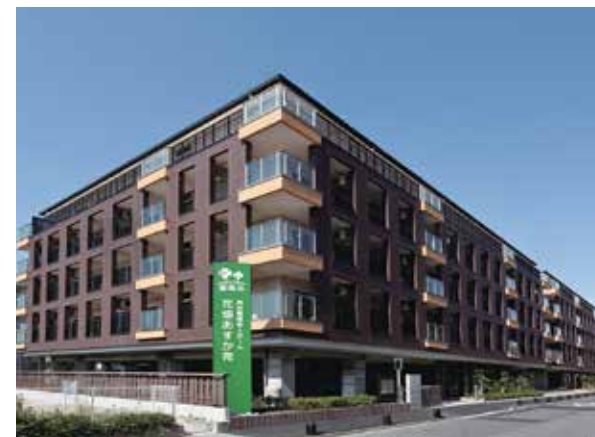
（仮称）特別養護老人ホーム 第二足立新生苑 地上5階（1階RC造、2～5階木造）耐火建築物 延べ面積9,773 m²
