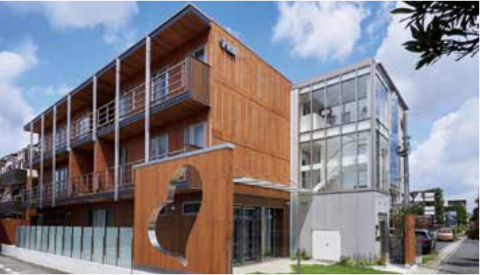
東和ハイシステム株式会社 社員寮新築工事 平成28年施行CLT 関連告示を導入したCLTパネル工法。燃えしろ設計によるCLT現し仕上げ。
