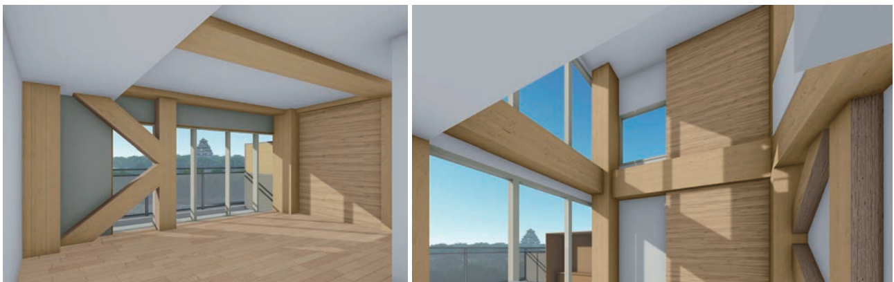
LVLのブレース、CLT耐震壁をあらわにした室内のイメージ（左：6階、右：7階）
