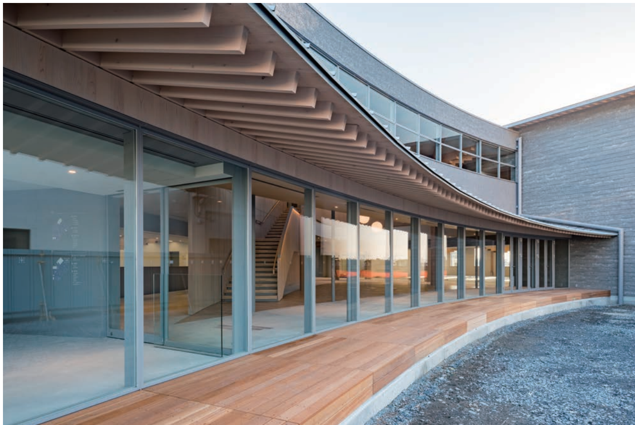
ヨリアイホールのウッドデッキ
