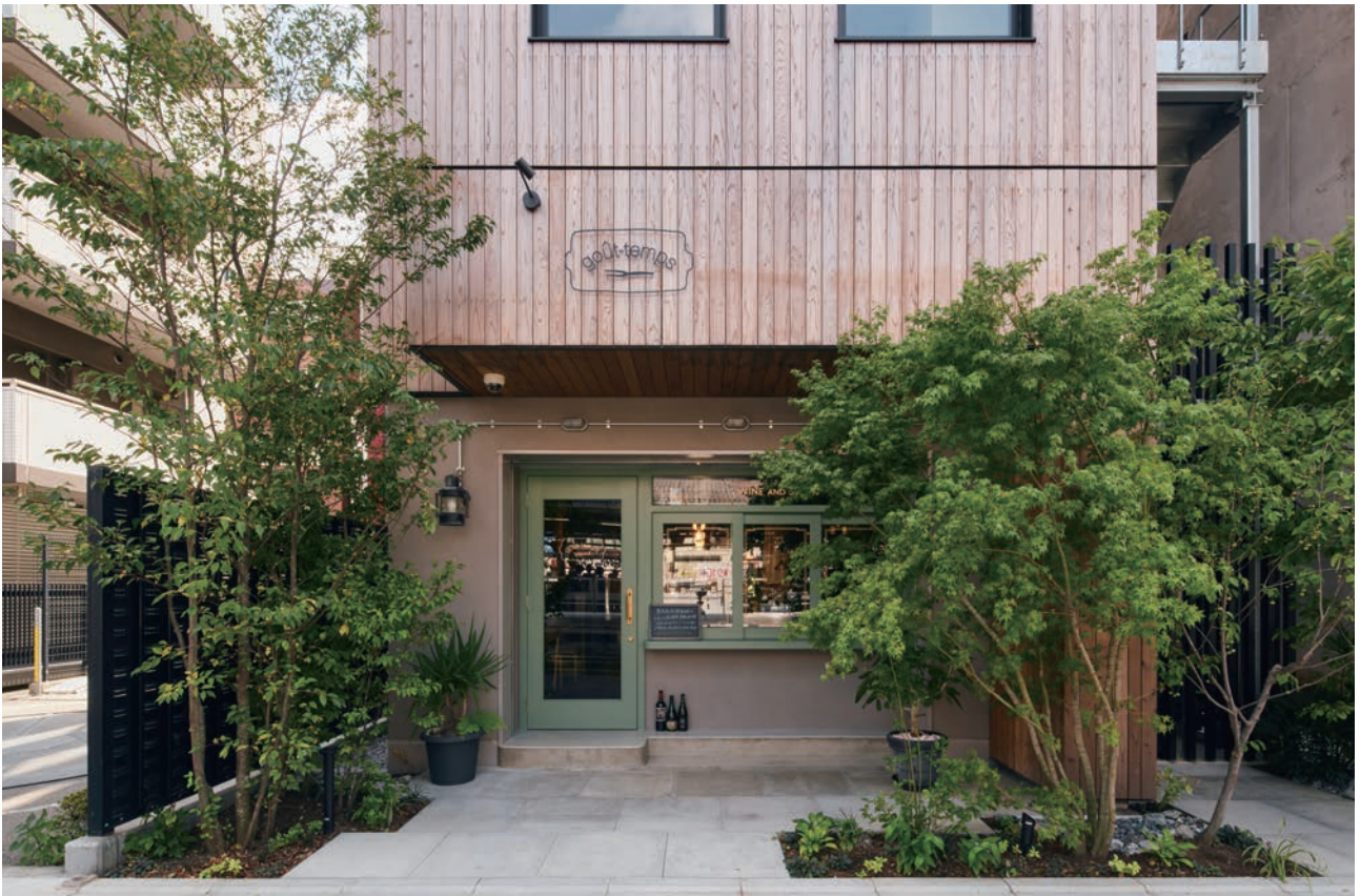
北側から 1 階テナントスペースを見る
