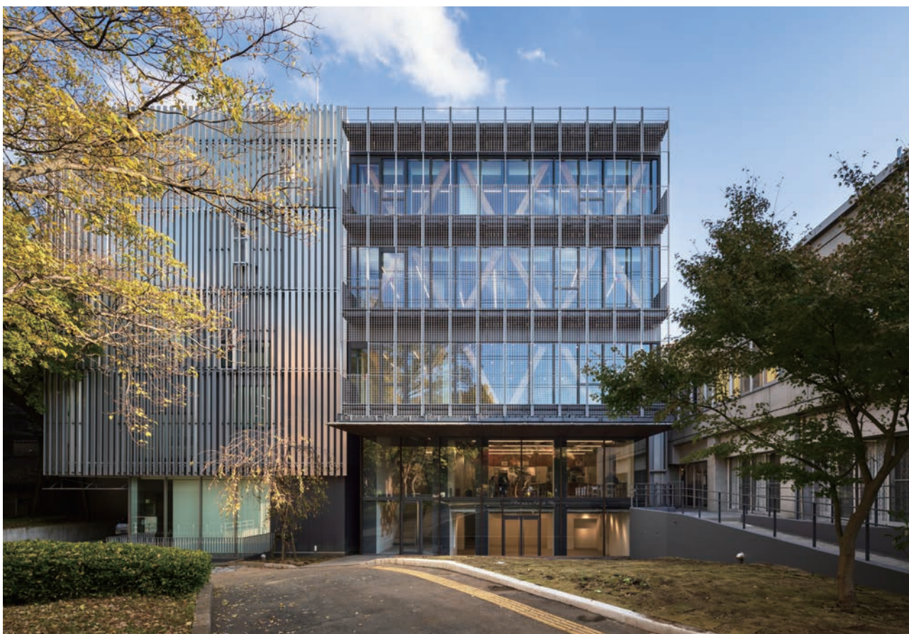
西側正面外観
