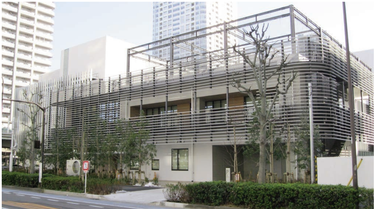
内部の木質化との連続性を図る外観。ピロティ部へ樹脂含浸処理積層木材を使用
