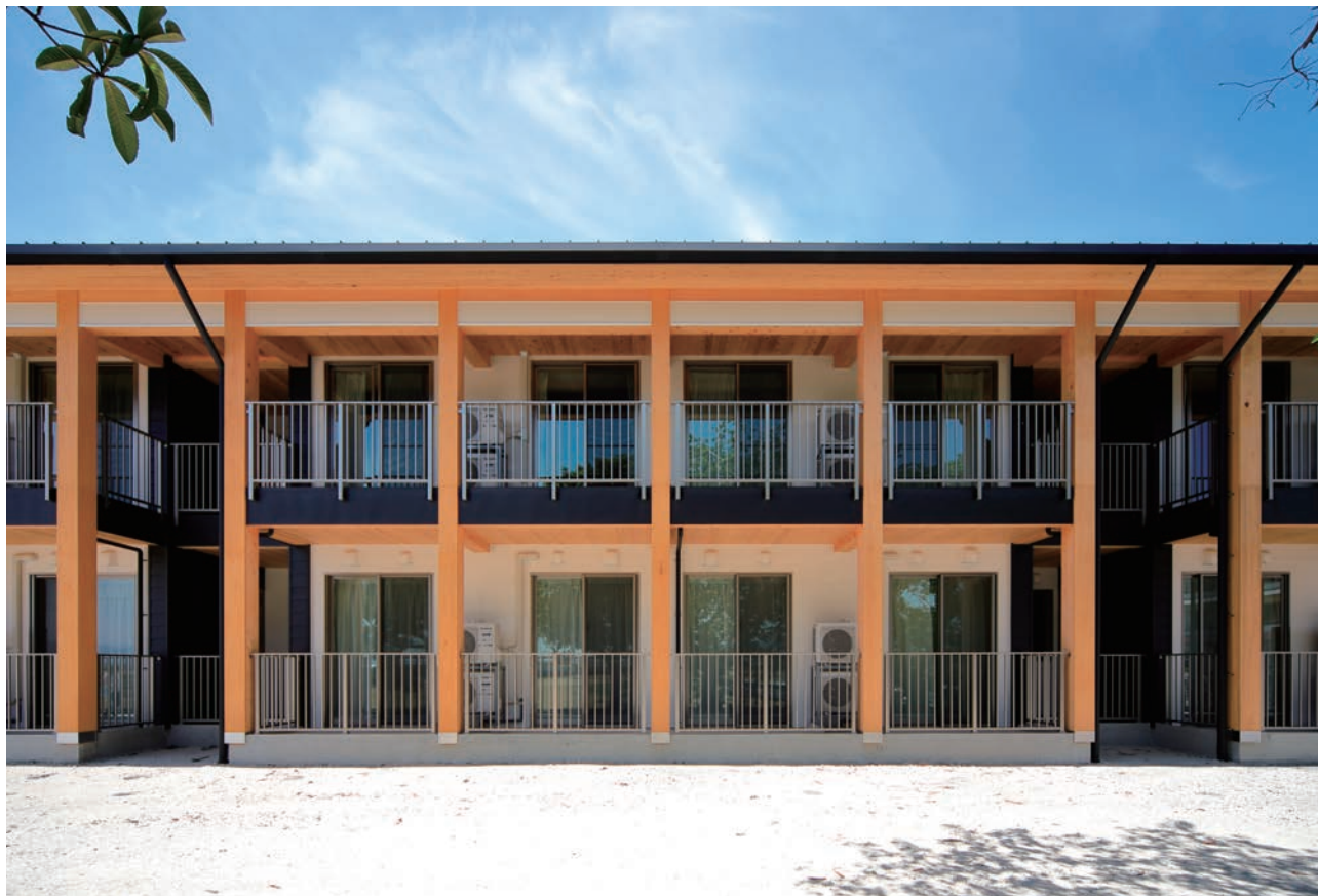
東側正面外観
