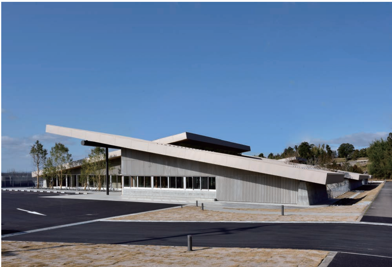
東側から見る外観
