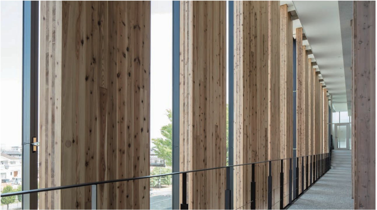
北側カーテンウォールのCLTバックマリオン
