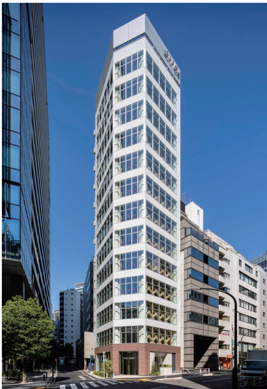
東側から見る外観
