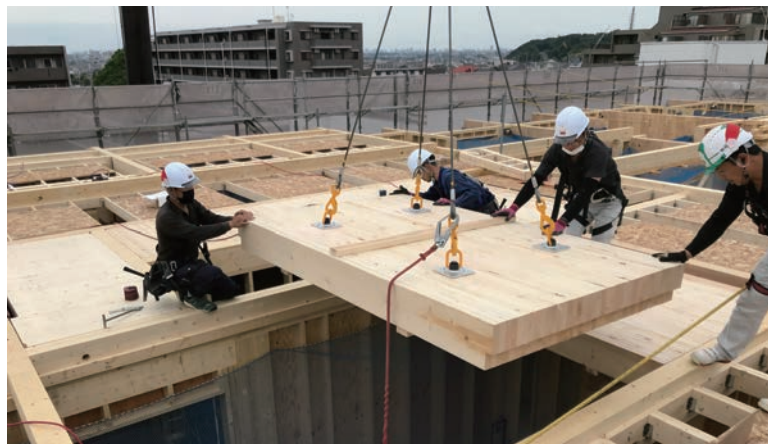
NLTの施工風景
