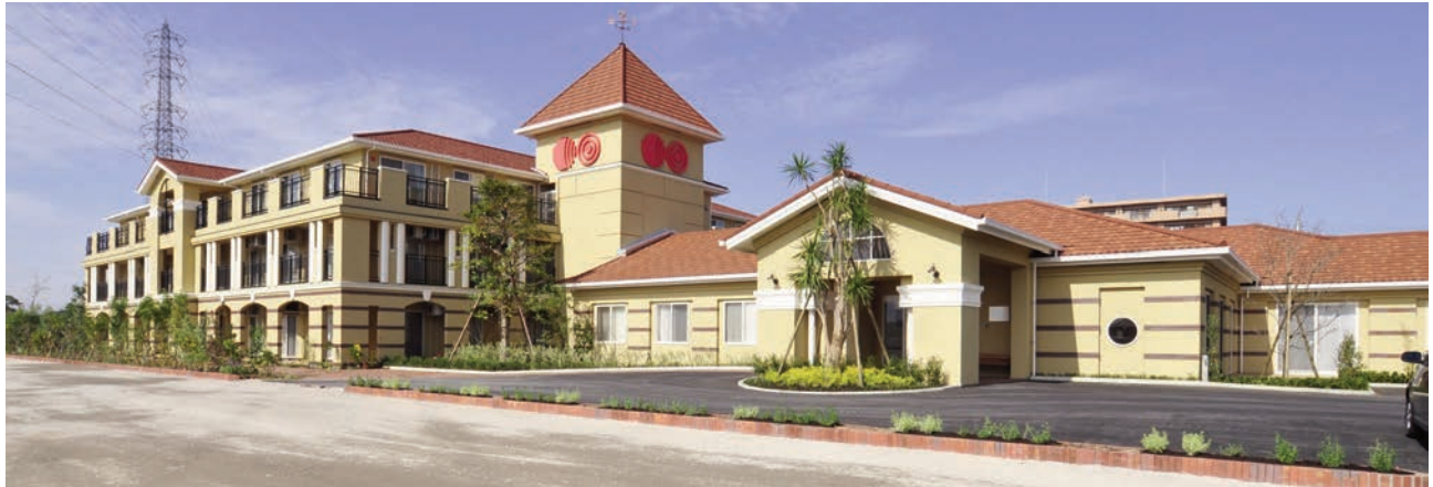
東側から見る完成した建物の全景
