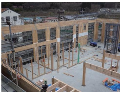
外周部2層通しCLTパネル壁施工の様子
