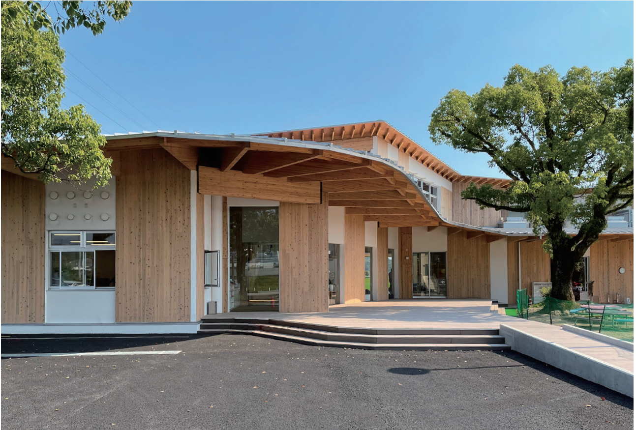
北側、玄関まわりの外観
