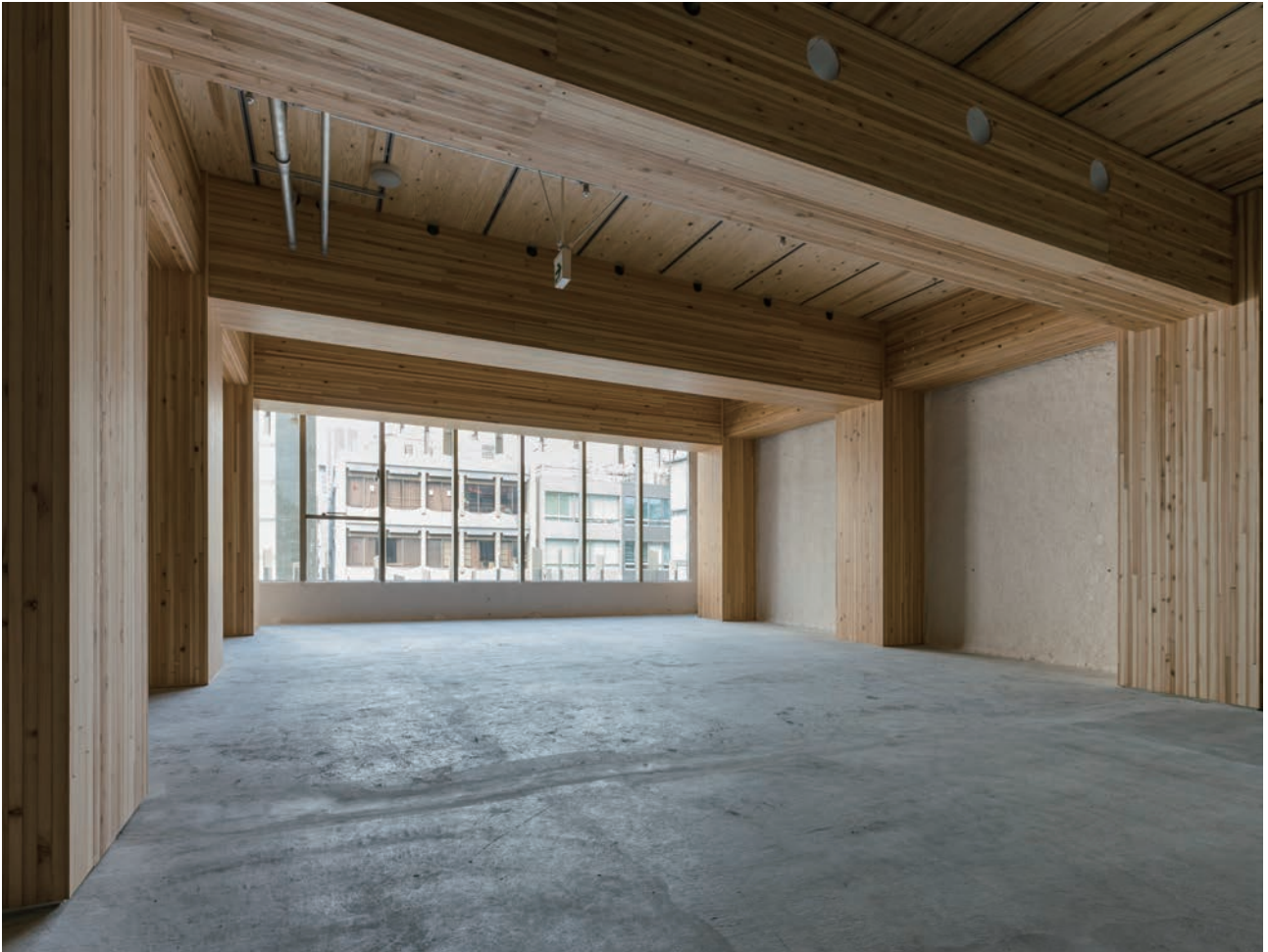
テナントによる内装前のスケルトン時の内観
