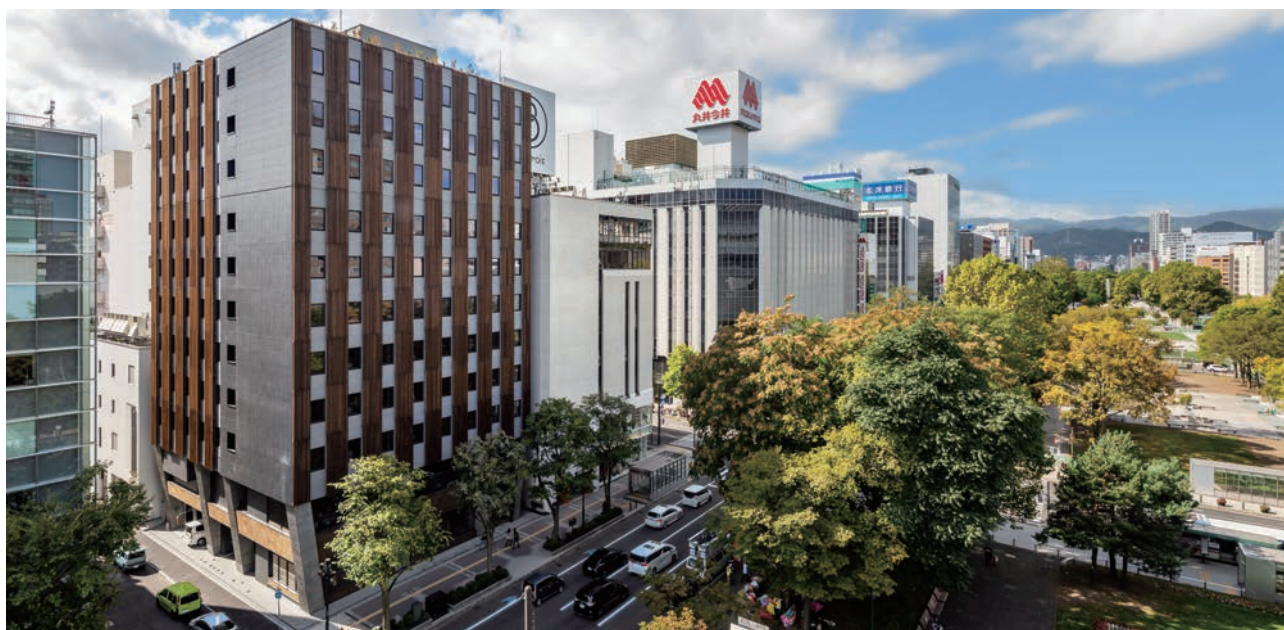
大通公園に面して建つ外観
