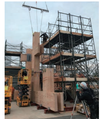
実大施工試験の様子
