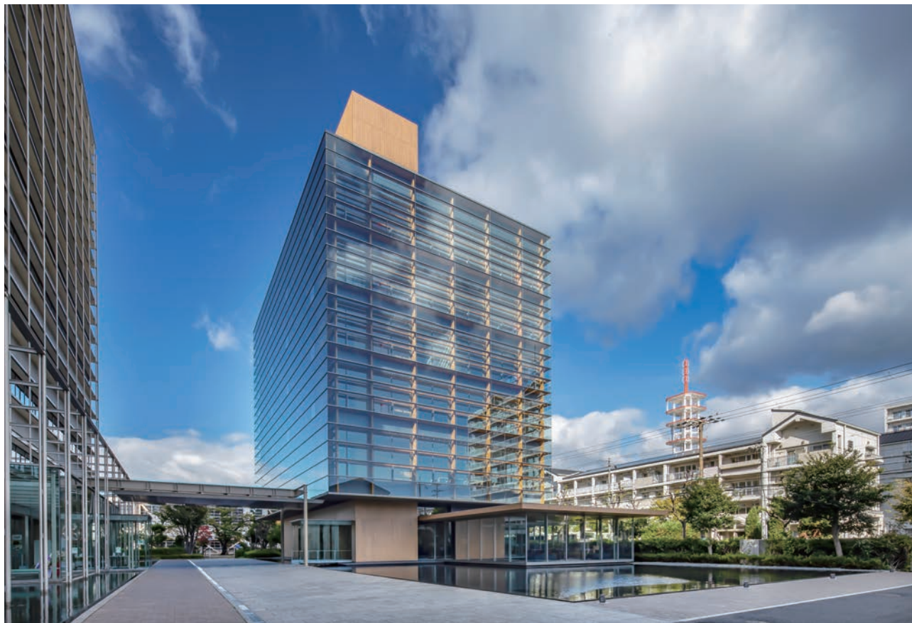
東からの外観 (左は既存本社棟)
