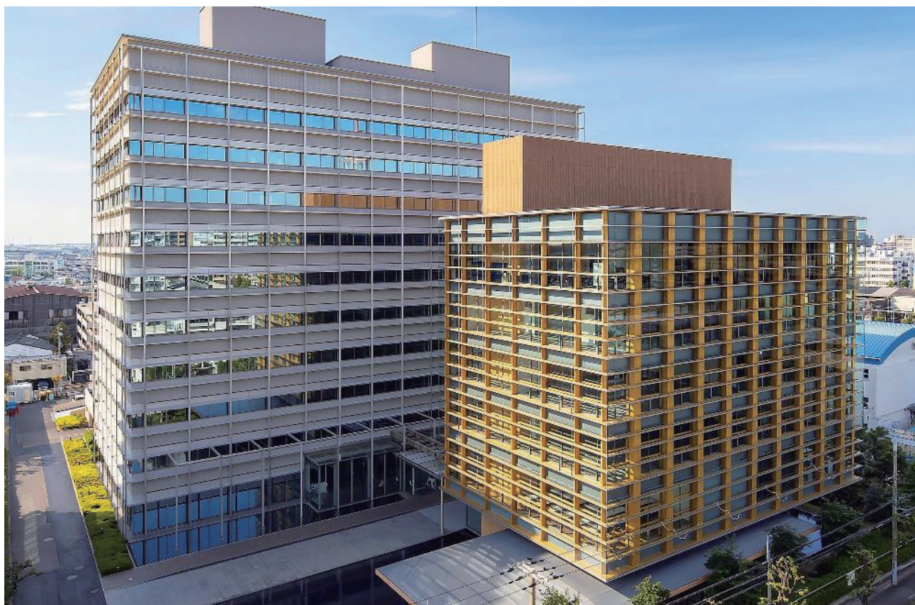
北東側からの外観 手前が今回の研修センター、奥に既存本社建物
