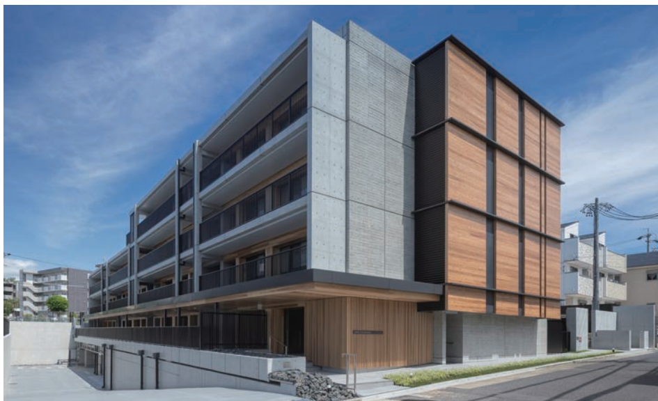
北西、エントランス側からの外観
