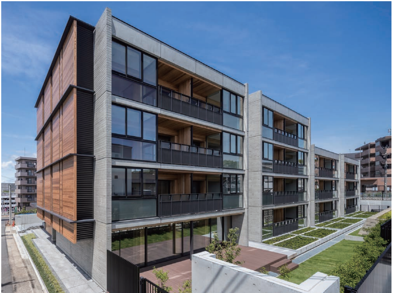
南側からの全景
