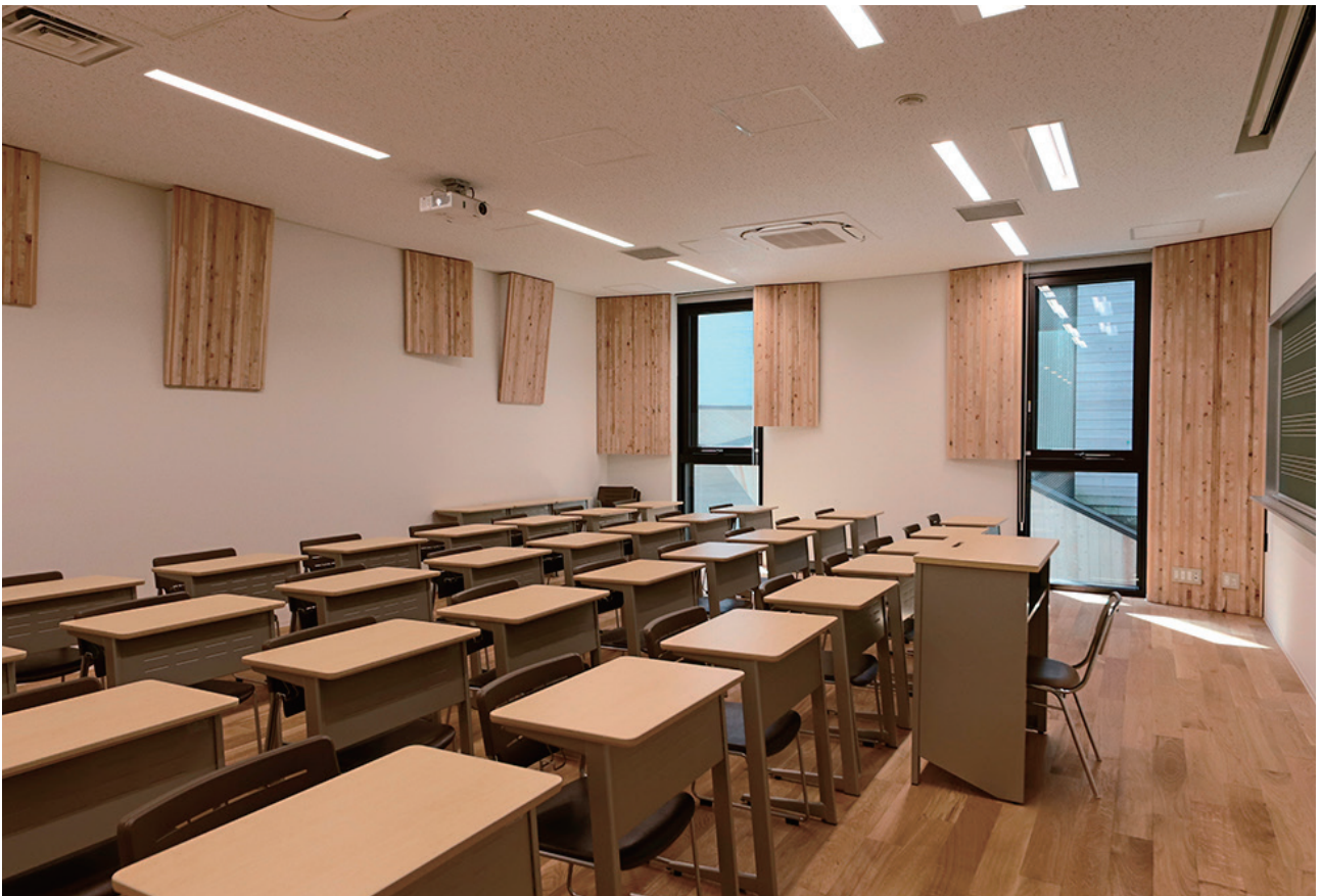
CLT の端材を利用した教室の内観
