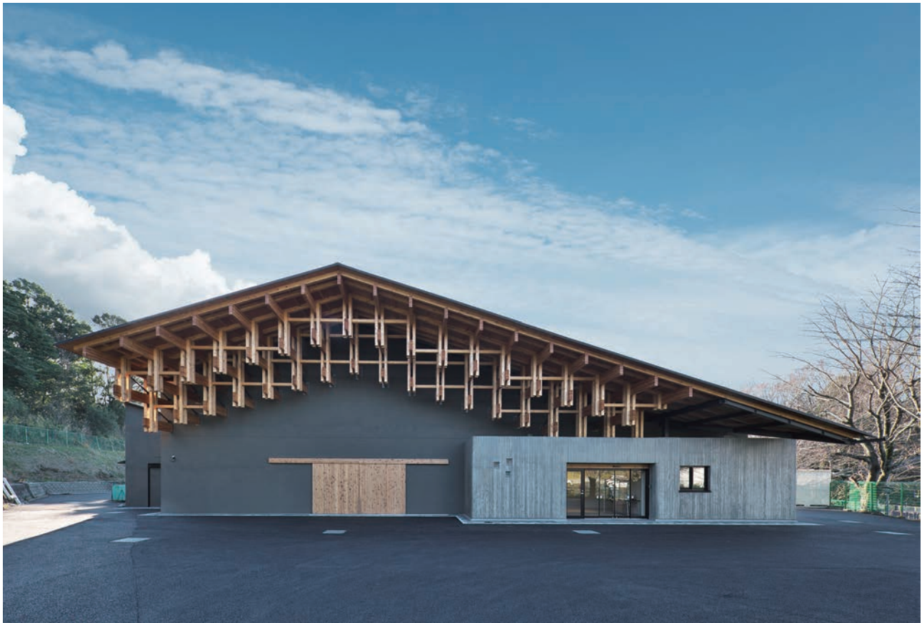
北側よりメインエントランス側の外観
