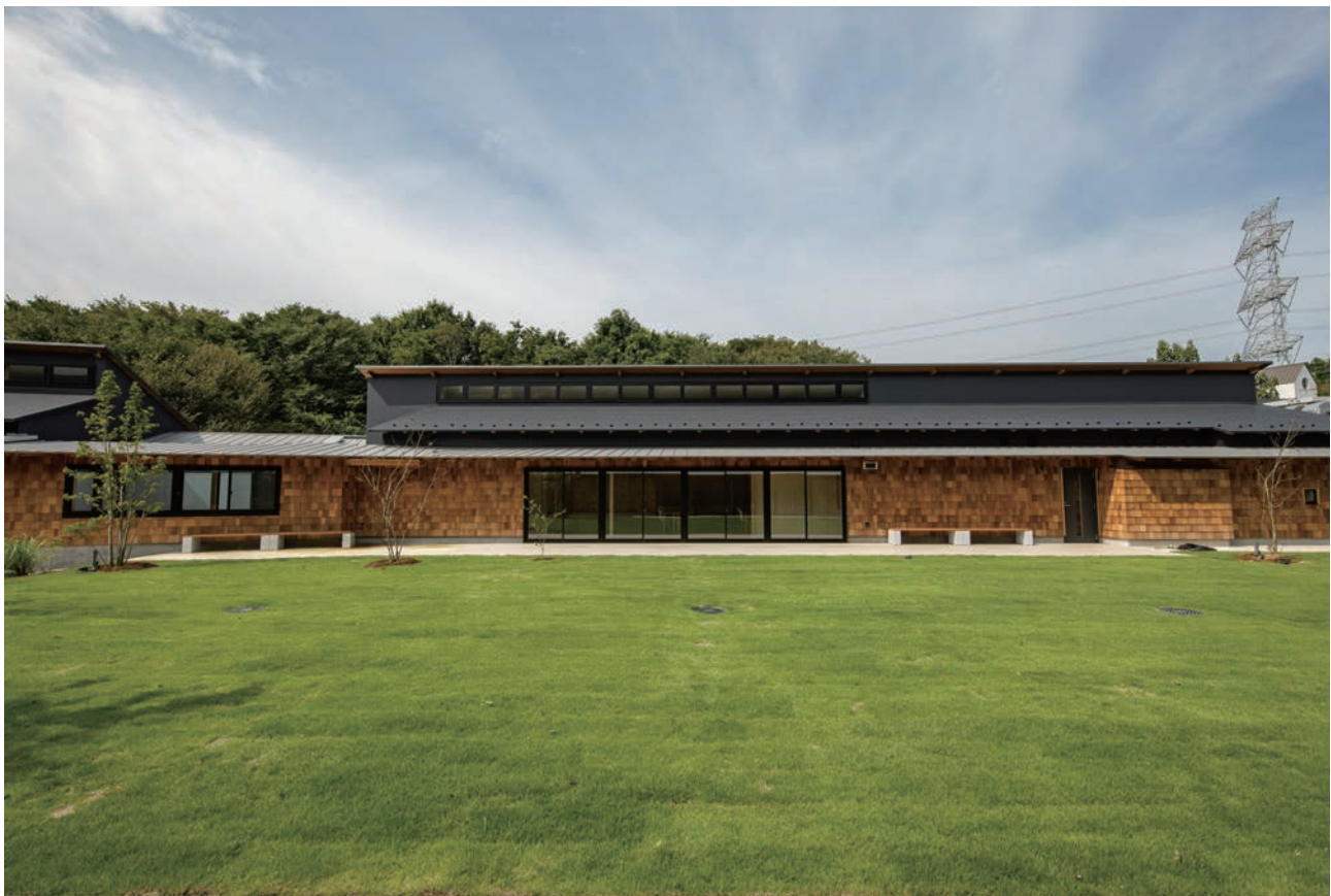
中庭越しに東側の居住ユニット棟を見る
