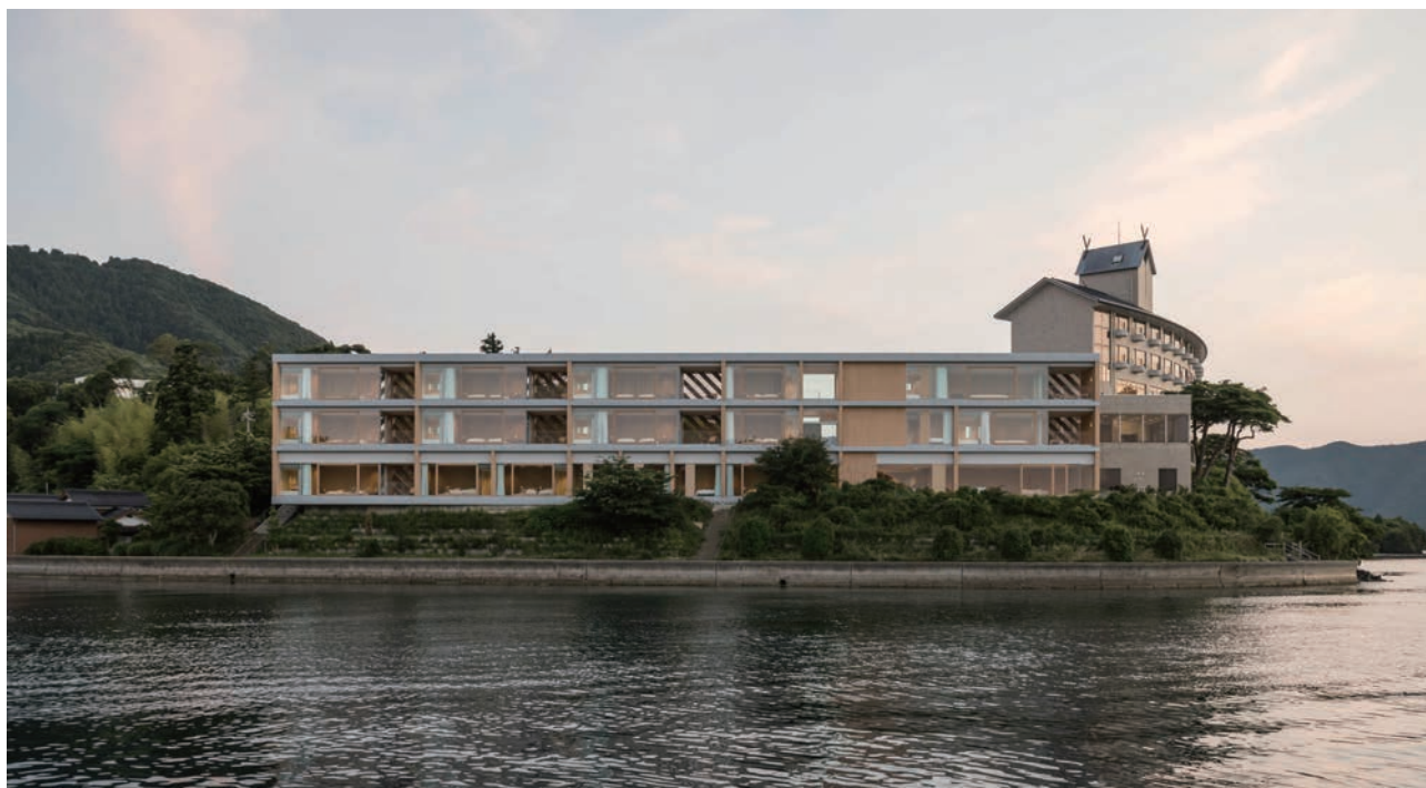
海からの外観
