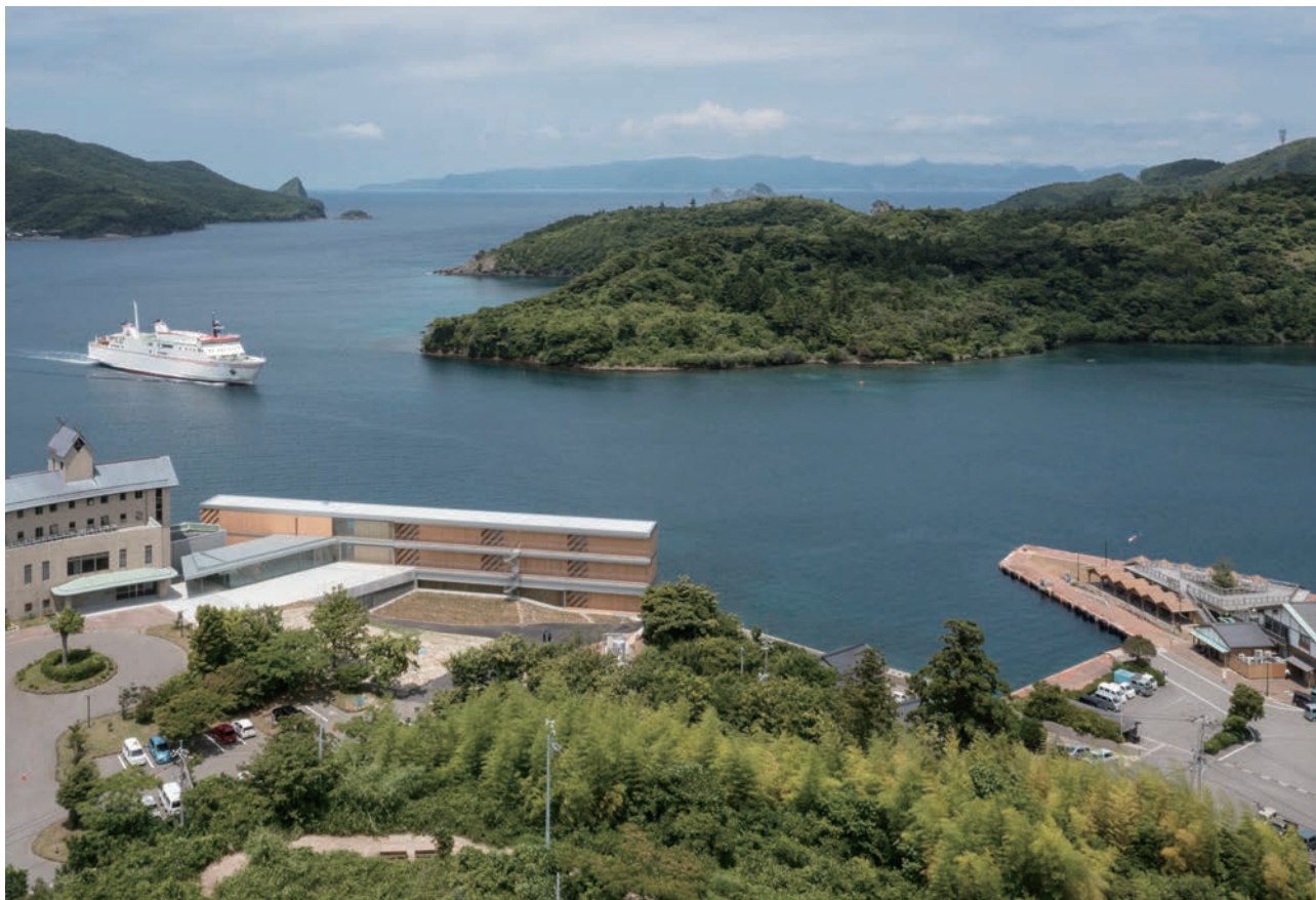
隠岐の海に向かって建つ外観（左に既存棟、右にフェリーターミナル）
