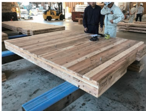
CLT 版の工場での製作
