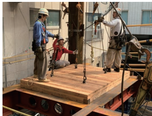
現場での CLT 版の吊り込みの様子
