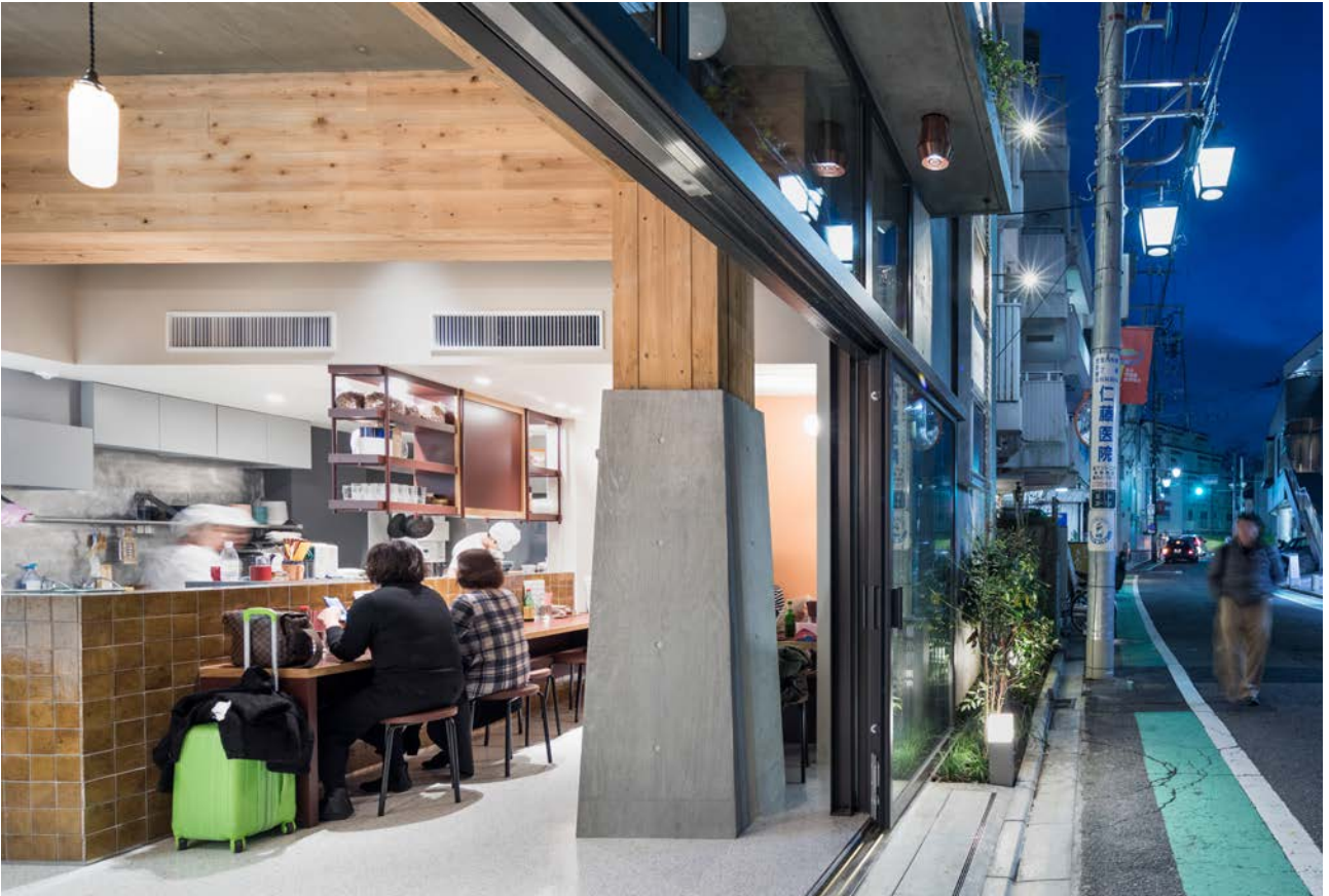
街路より1階店内を見る 木造東ね柱・重ね梁のフレームがよくわかる
