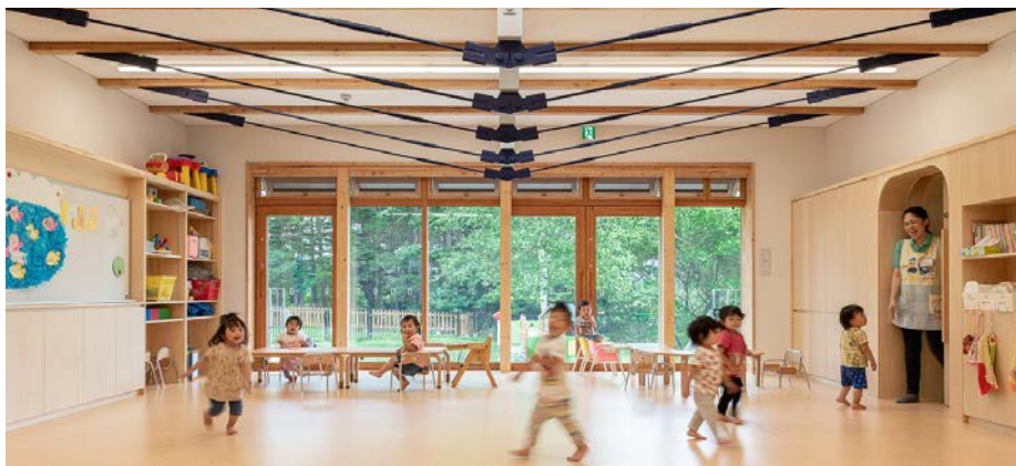
張弦梁架構の保育室
