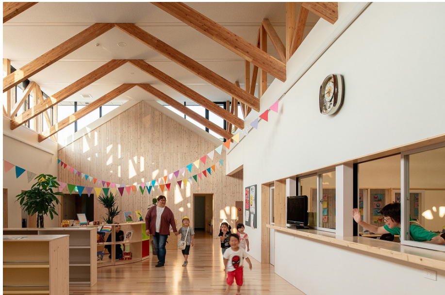
3ヒンジ方杖構造の絵本のまちあいホール 右は職員室
