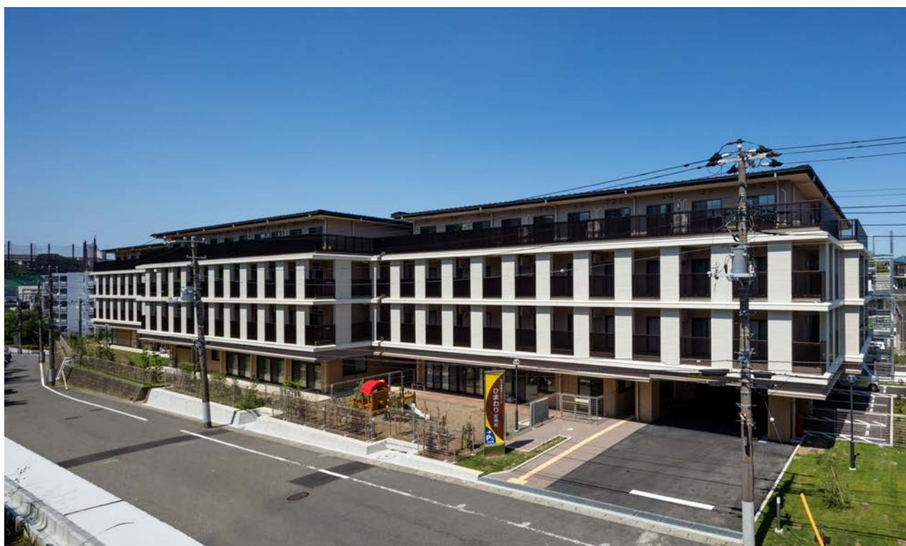
南側からの全景
