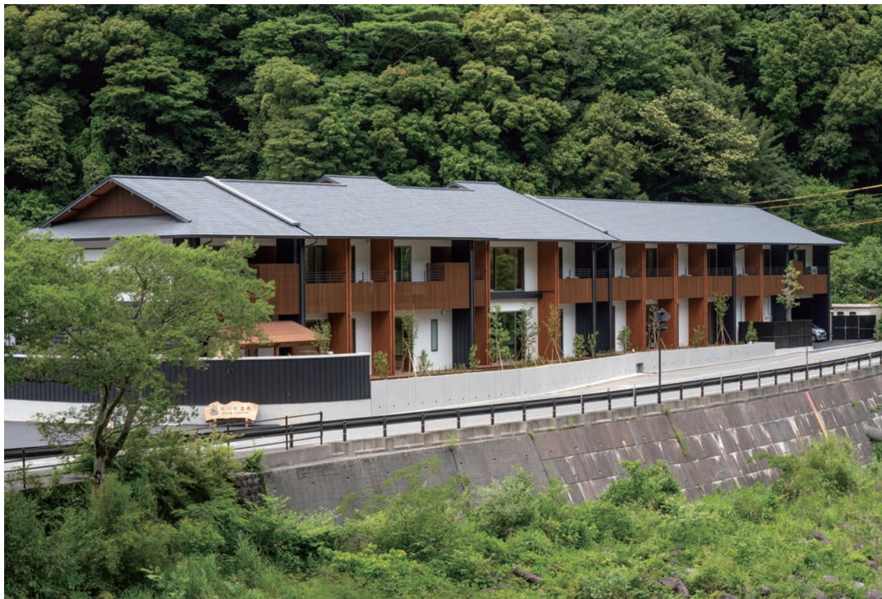
南側からの全景
