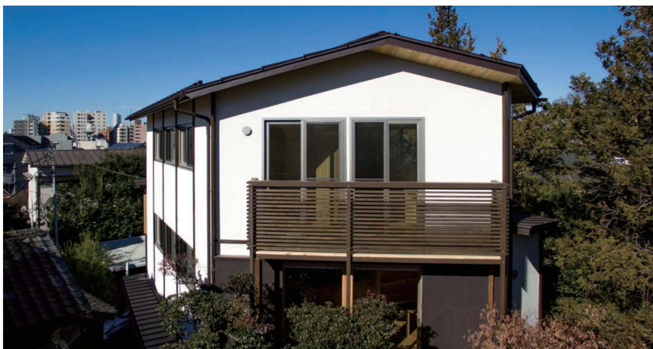
南側からの外観
