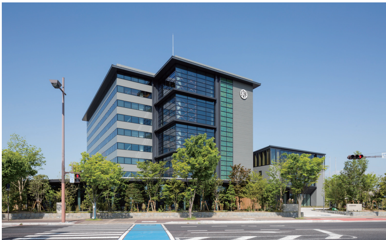
東南面外観 正面に 5 階建事務所棟、右に低層の会議室棟
