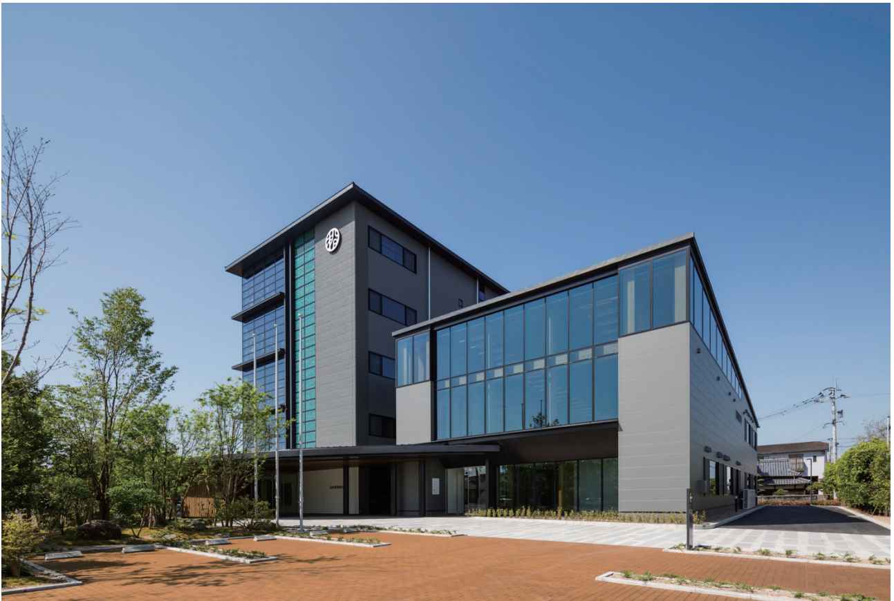
北東面外観 左：事務所棟、右：会議室棟
