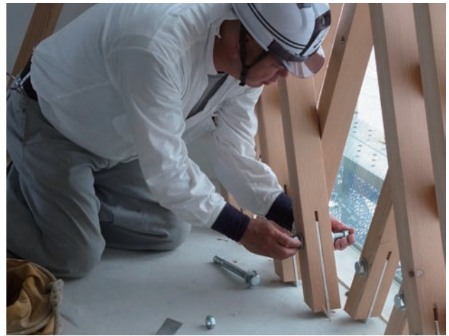
斜材の取り付け
