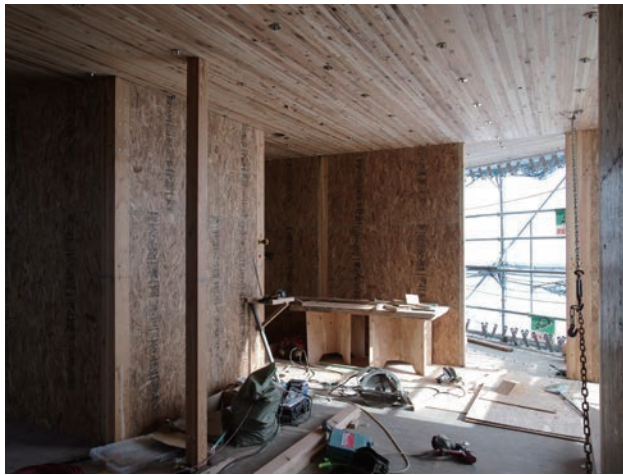
耐火被覆前の内部の様子
