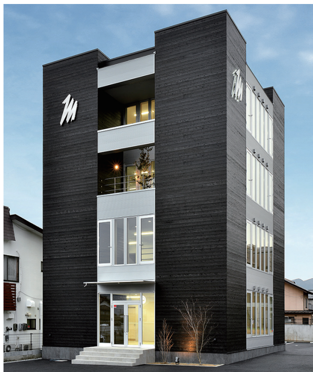
北東面外観全景
