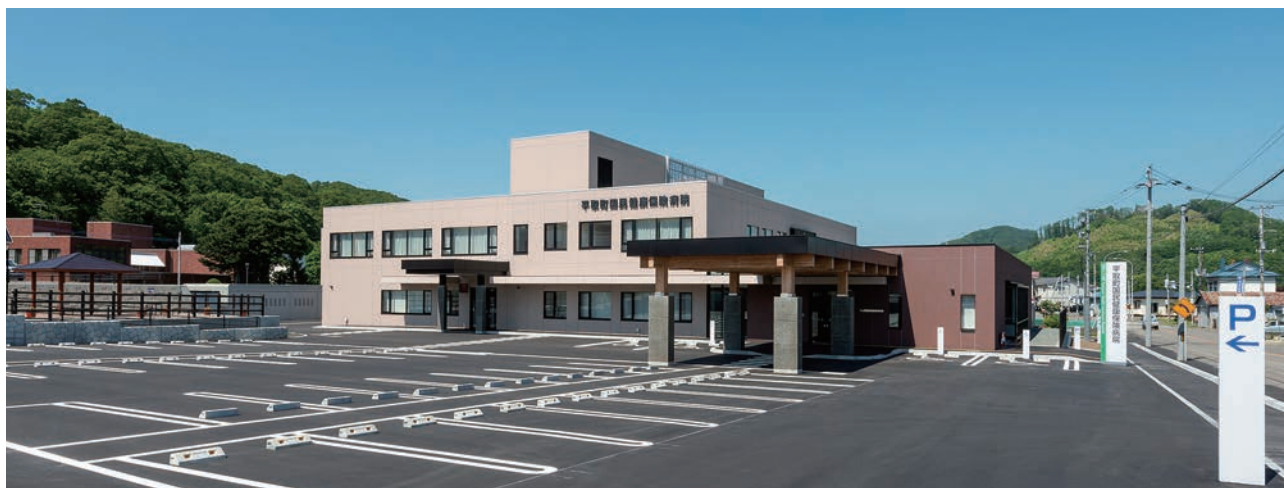
南側からのエントランス側外観
