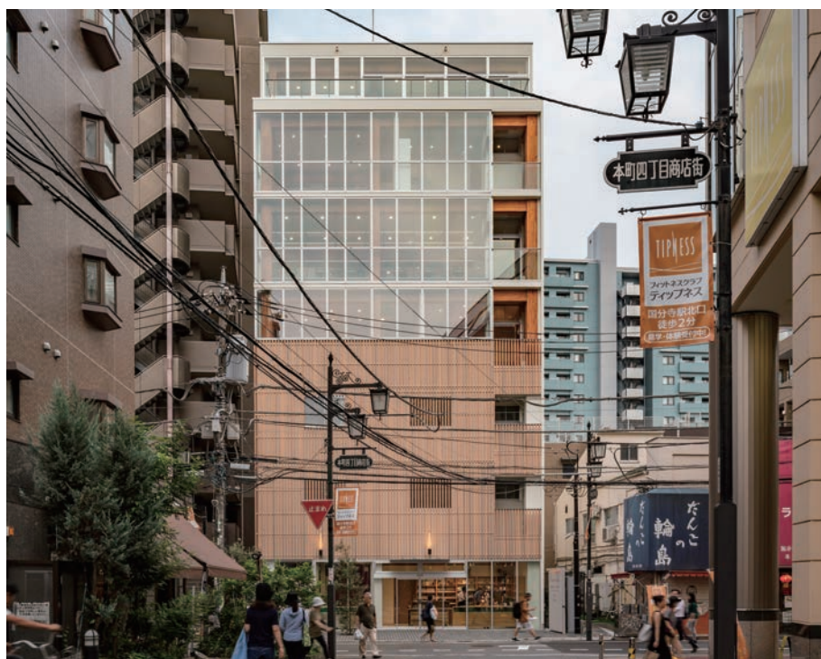
北側から見る外観
