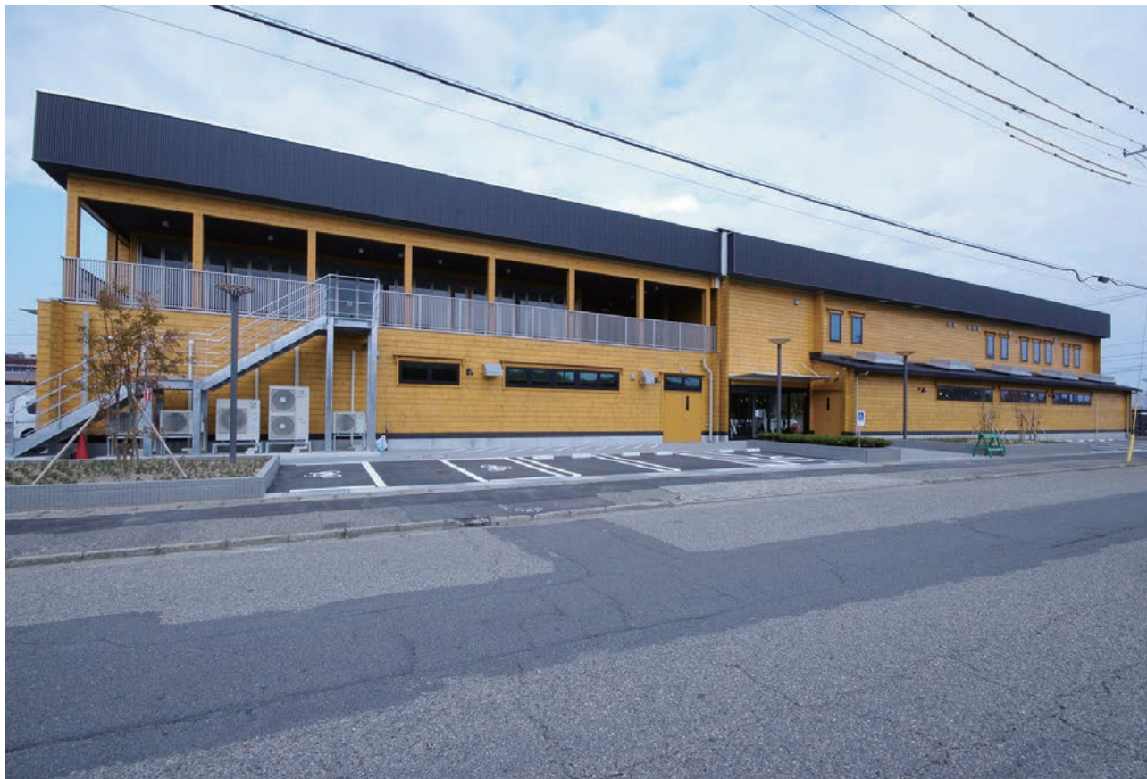
南側からの外観
