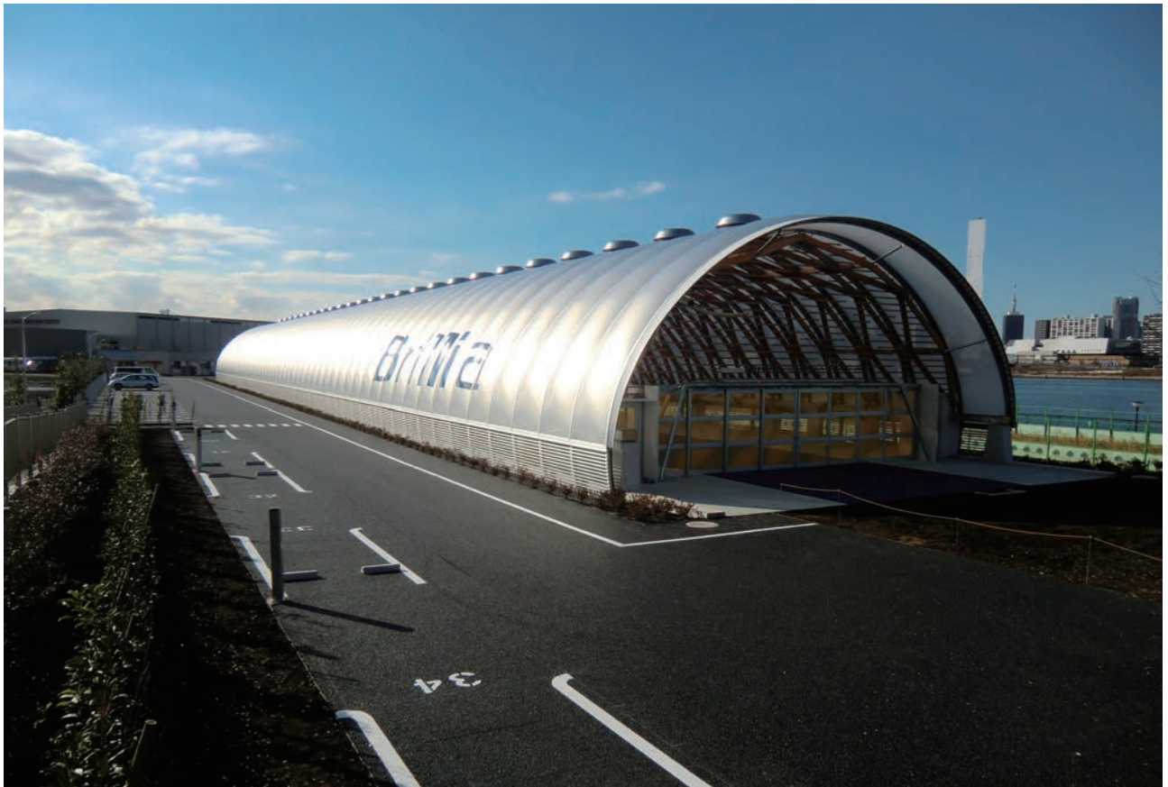
東側からの外観
