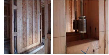
タイダウンシステム 施工状況(本プロジェクト2階部分)
