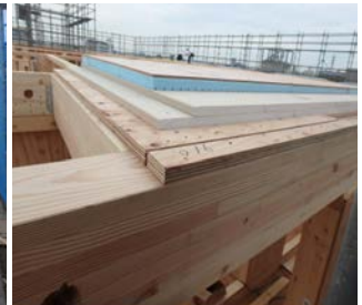
バルコニーユニットの施工状況
