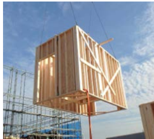
個室ユニットの施工状況
