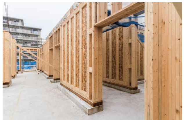
ミッドプライウォールシステムの設置状況
