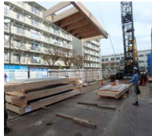
バルコニーユニットの施工状況
