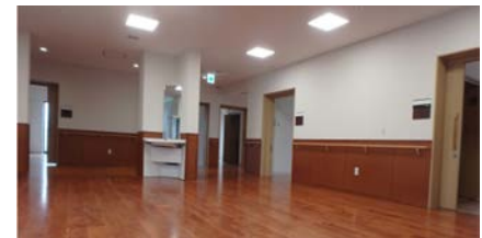
内装の木質化の施工状況 (本プロジェクト5階共同生活室部分の フローリング・腰壁)
