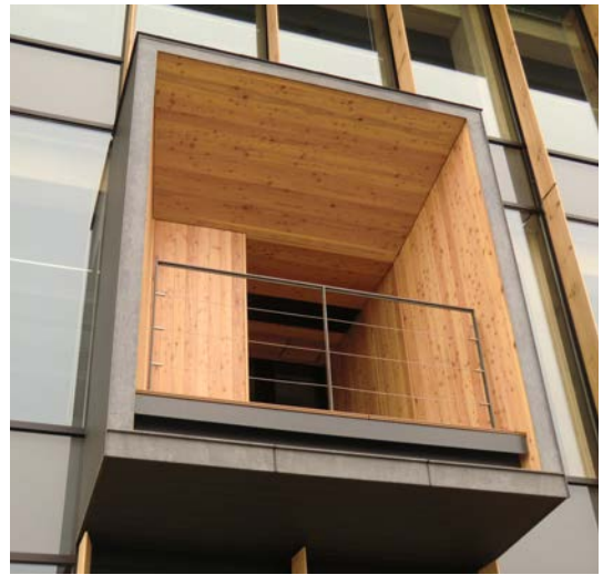
県産材使用のテラス
