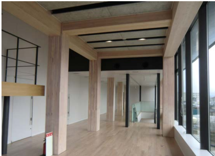
木質ハイブリッド耐火構造の柱・梁をあらわした縁側スペース
