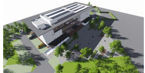
環境配慮を施した庁舎
