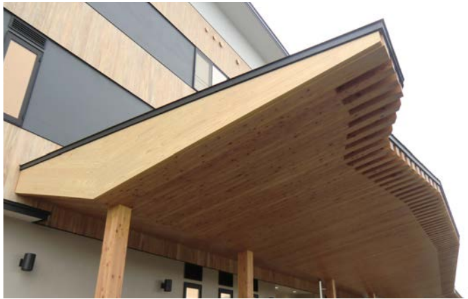
エントランスの大庇
