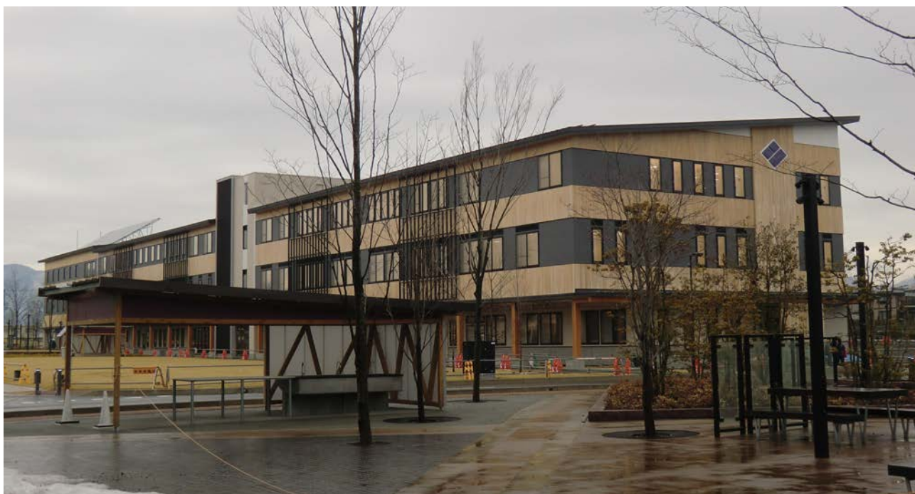
外部からも柱、梁、ブレースの木組み構造が見える親しみやすい外観
