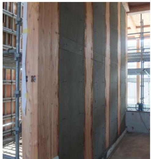
木造+RC造の混合構造耐震壁
