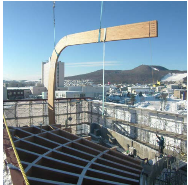
集成材の建て方風景
