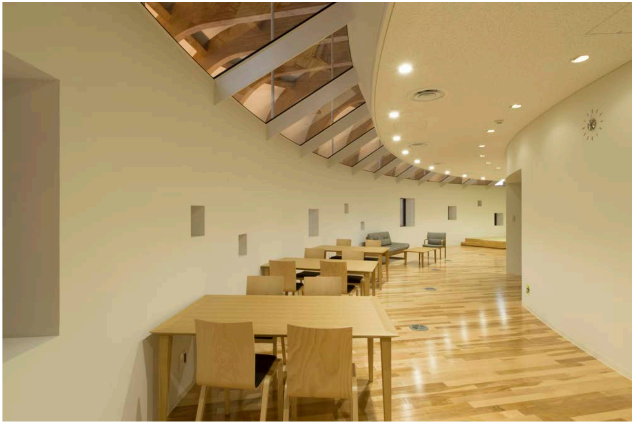
営業室2階は屋根からの吊り支持により、1階に柱のない空間を生んでいる
