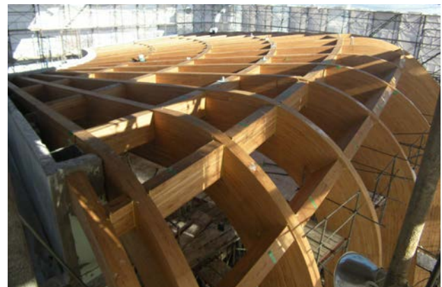
集成材の建て方完了時
