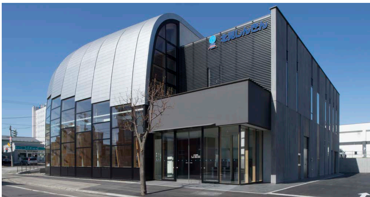
東側からの外観
