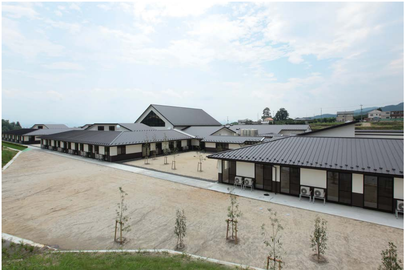
北側からの外観
