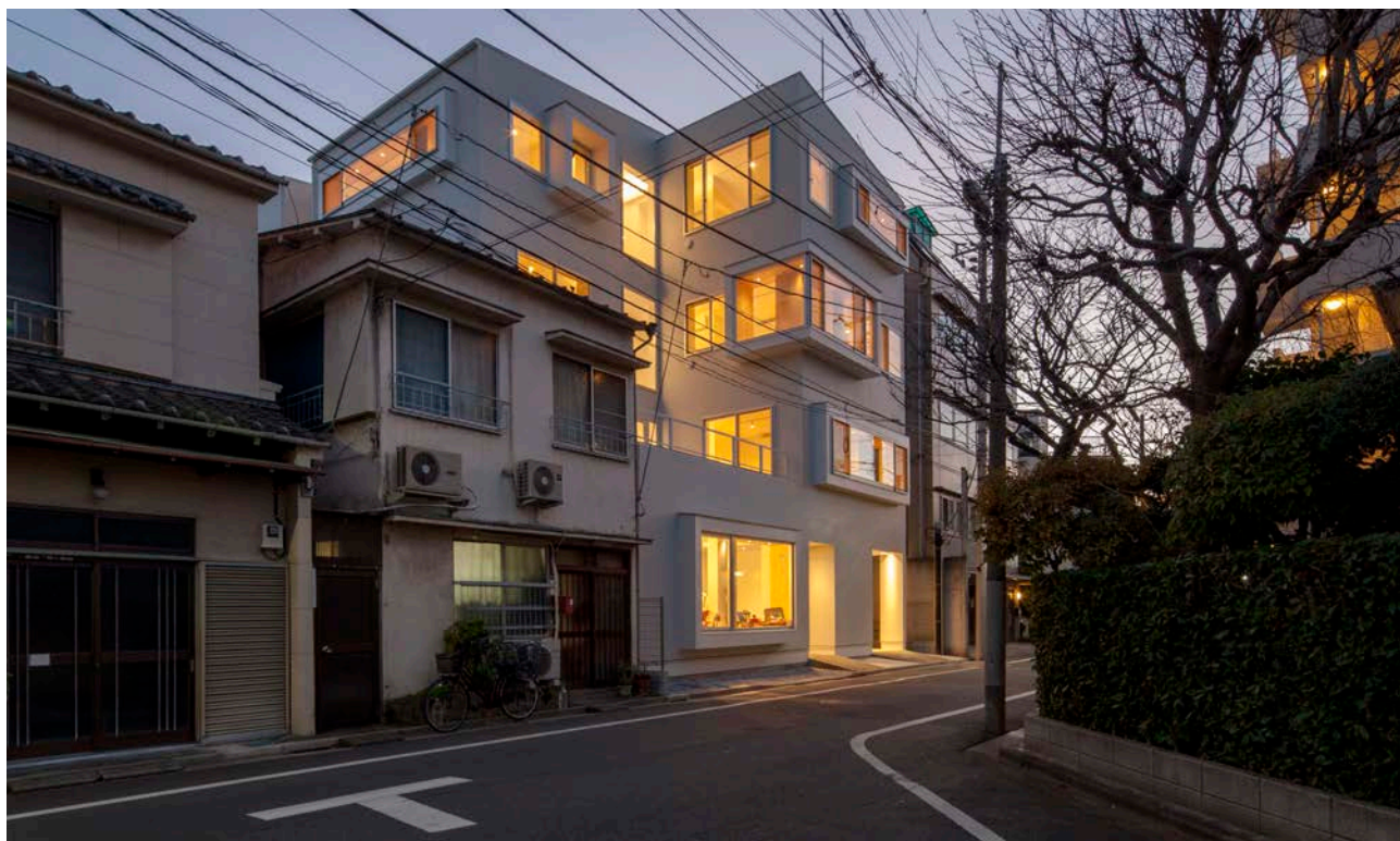
北側道路からの北および東面の外観（夜景）
