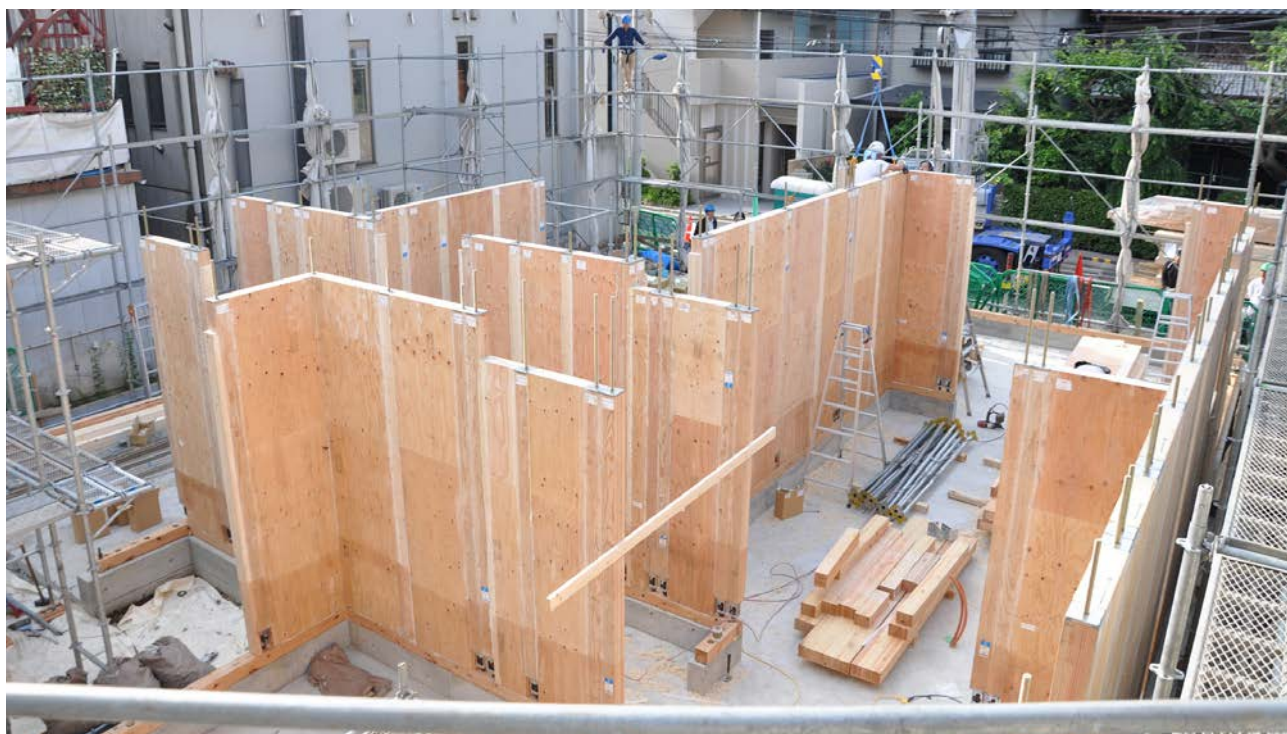
躯体パネル建て方の様子
