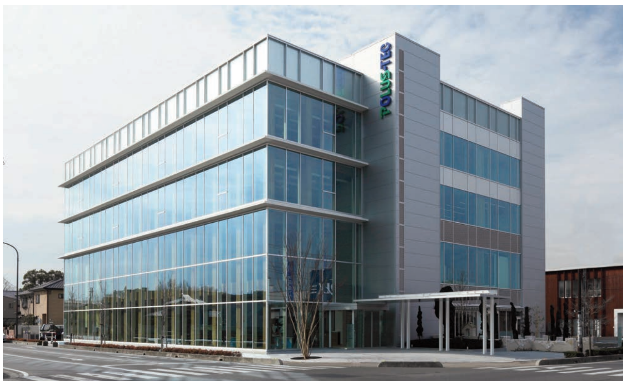
建物の外観は、LOW-Eペアガラスを透して、木質ハイブリッド集成材の重厚な柱と梁を窺うことができるデザインとなっている
