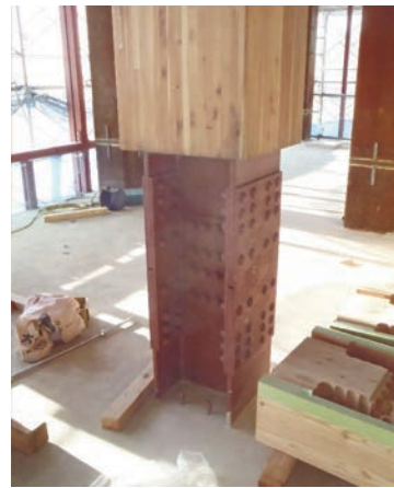
柱脚、ハイブリッドカバー設置状況
