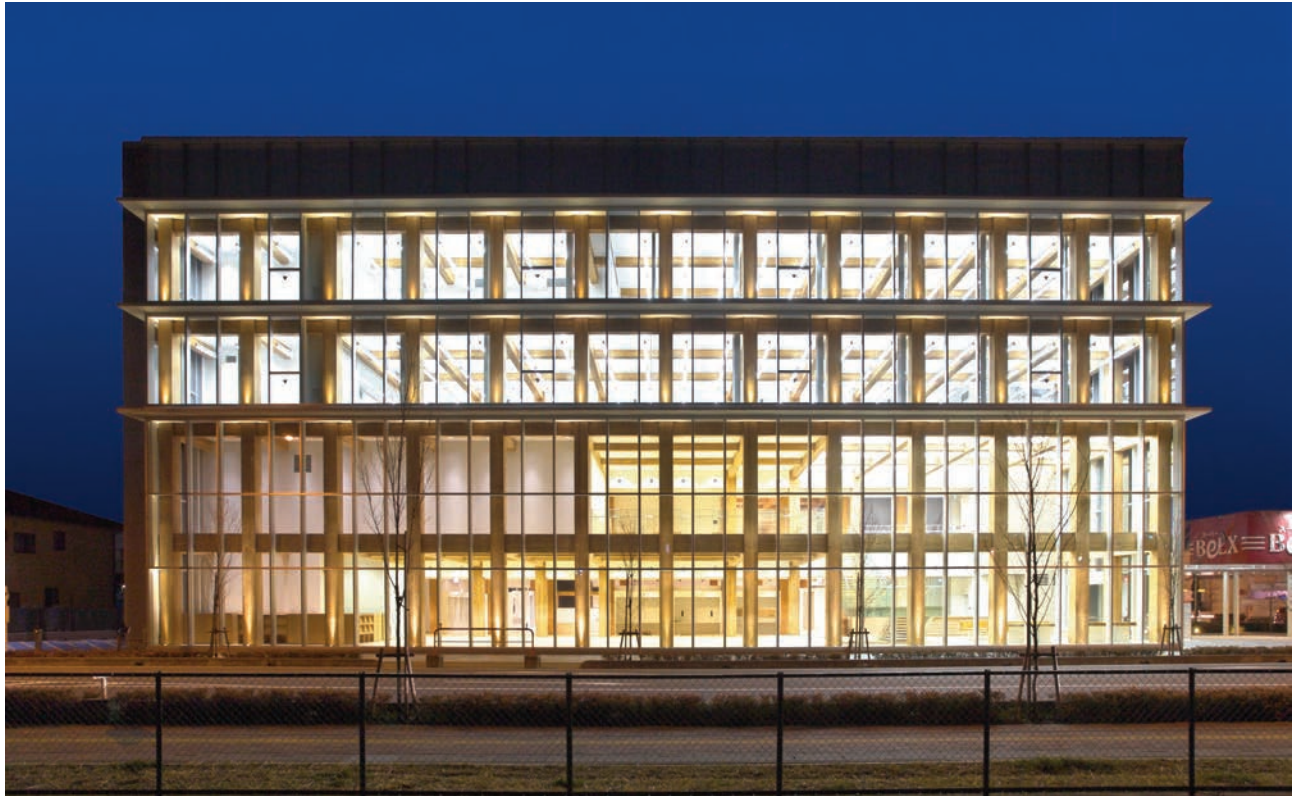
ライトアップされた建物の夜景。ハイブリッド集成材の柱と梁が浮かび上がる
