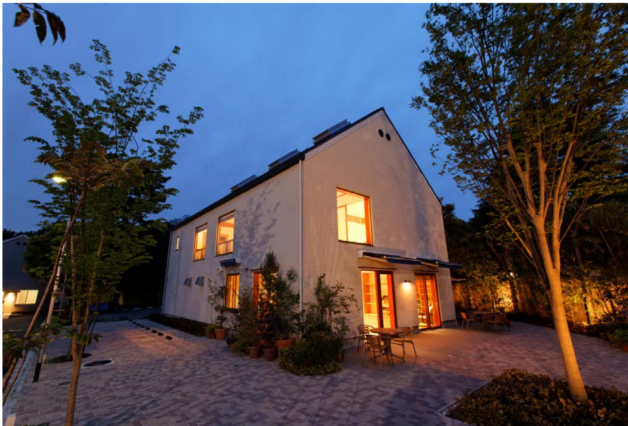
目白通りへ向けた正面外観
