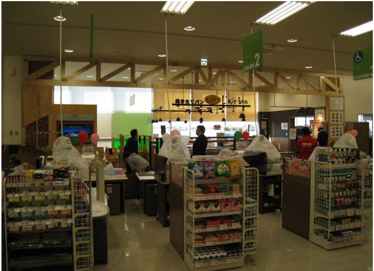
店内の大空間に露出する木造トラス
