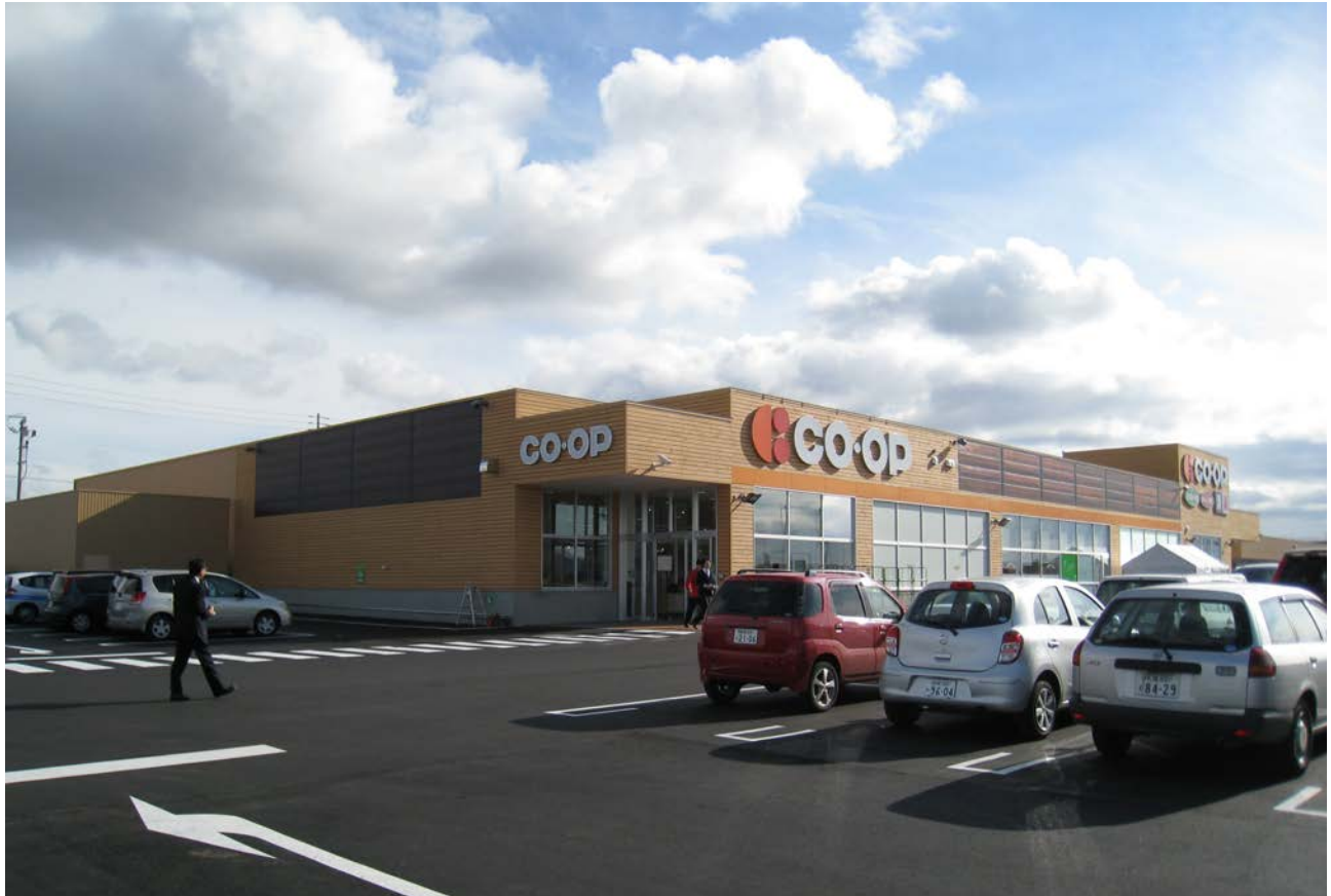
枠組壁工法で作られた大型小売店舗の外観
