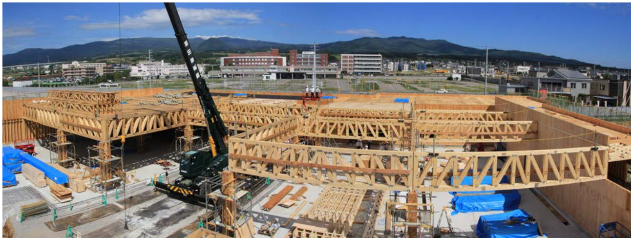
施工中のマルチウォールシステムと木造トラス
