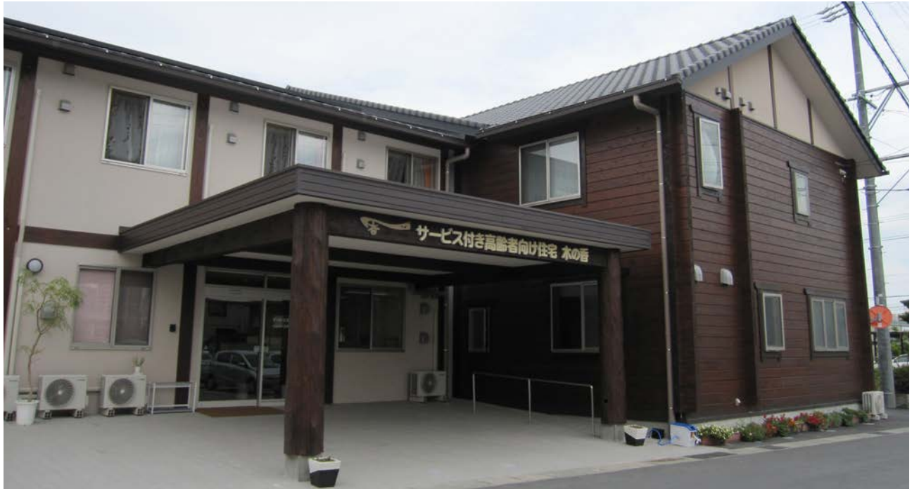
左側は軸組構法、右側は丸太組構法の、平面混構造の総 2 階建て建物の外観。2 階は高齢者賃貸住宅
