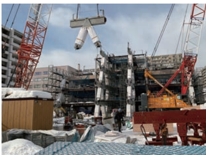
屏風建て方式による建て方
