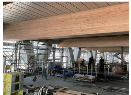
3階見上げ部の燃エンウッド梁
