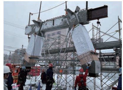
ユニット化による施工
