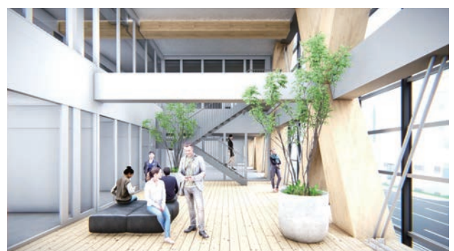
2～3階インナーテラス： 耐火集成材（燃エンウッド）の斜め柱と梁
