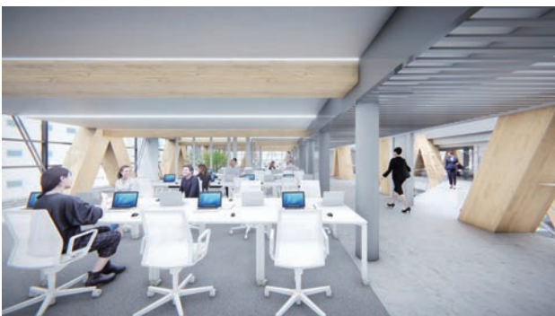
3・4階オフィス： 耐火集成材（燃エンウッド）の斜め柱と梁
