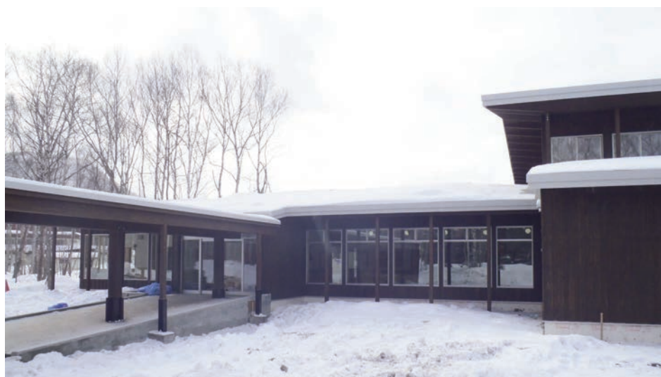
アプローチ、エントランスまわり
