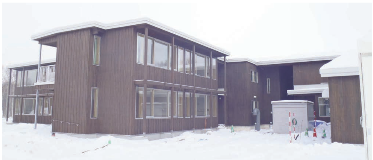
病棟部の外観
