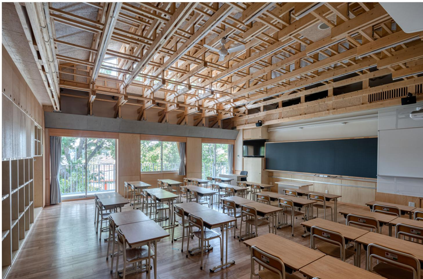
規格製材とLVLガセットによる
