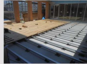
(13) 外部ウッドデッキ下地根太工事
