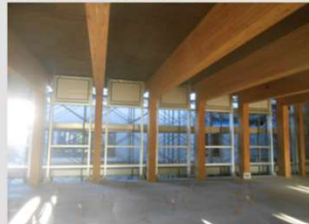
(4) カーテンウォール枠取付工事
