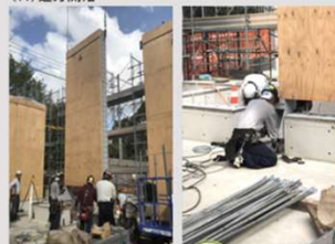
(13) LVL設置、建方精度確認後、HD板締め
