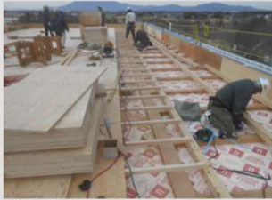
(5) 屋上下地取付
