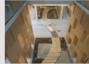
(14) インナーコートヤード工事
