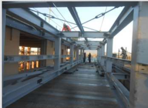
(3) トップライト鉄骨工事
