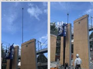
(14) PC鋼棒挿入
