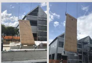
(12) LVL吊り上げ
