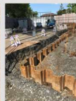
(4) 山留：シートパイル
