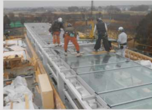
(6) トップライト硝子工事
