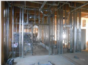
(7) 内部間仕切壁軽量鉄骨下地工事
