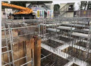
(9) 基礎下部コンクリート打設
