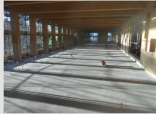
(2) 床スラブ コンクリート打設
