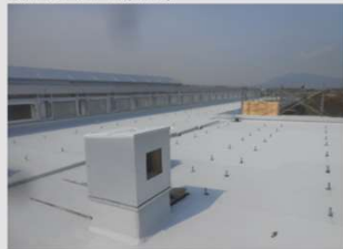
(8) 屋上防水トップコート工事
