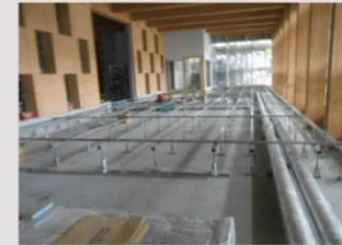
(12) 床下鋼製下地・換気ダクト配管工事
