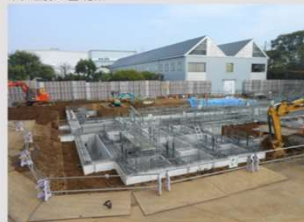
(10) 基礎立上りコンクリート工事完了
