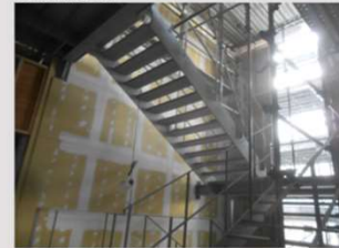
(11) 内部下地ボード工事
