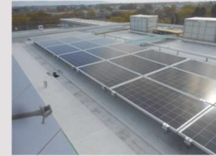
(10) R2F太陽光パネル設置工事
