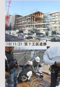
(22) PC鋼棒の本緊張(1000kN)
